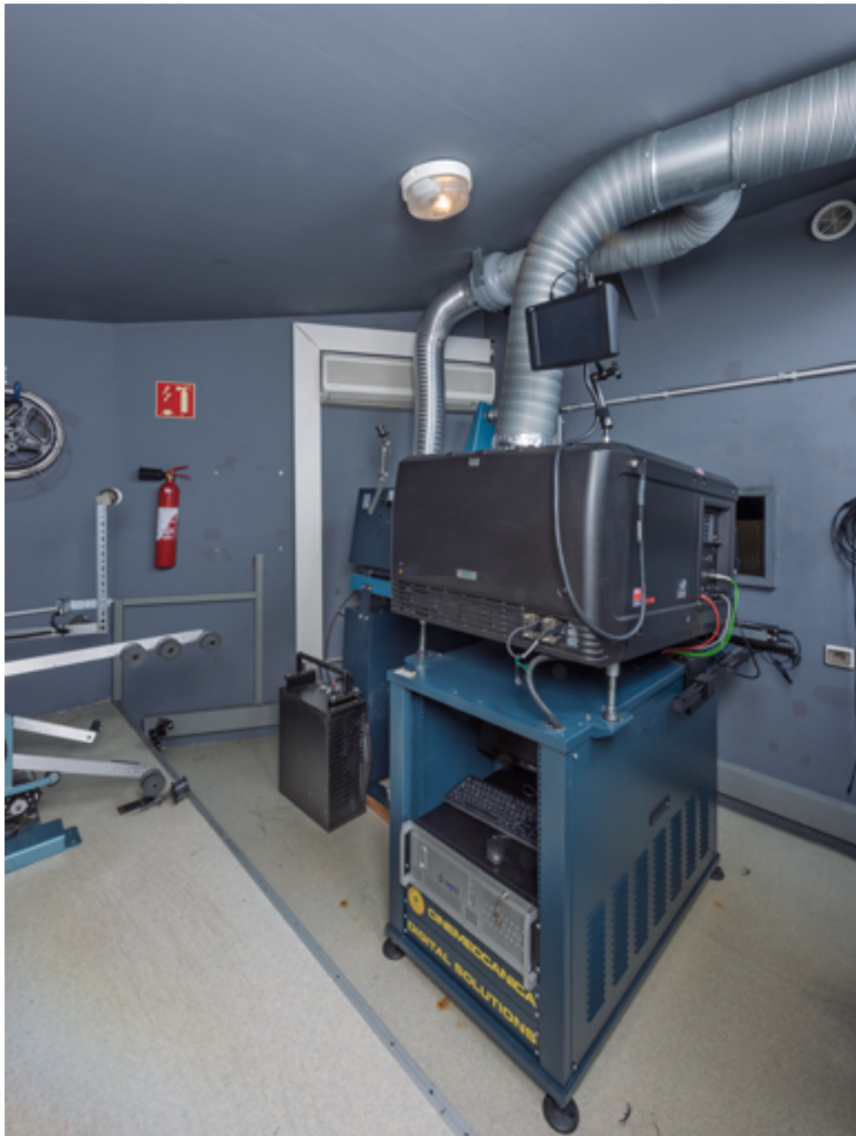
Cabine de la salle 1. Projecteurs numérique Barco (à droite) et argentique Cinemeccanica.
