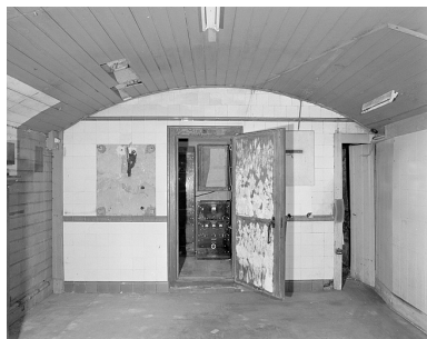
Vue d'ensemble. Phot. Jérôme Mongreville IVR43_20022501143X
