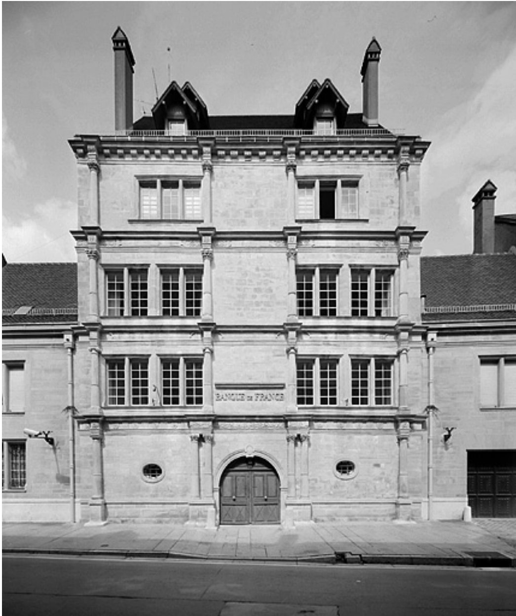
Façade sur la place.
