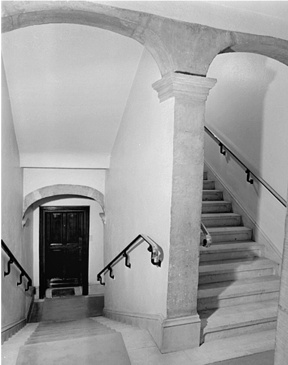
Escalier vu du palier du deuxième étage.
