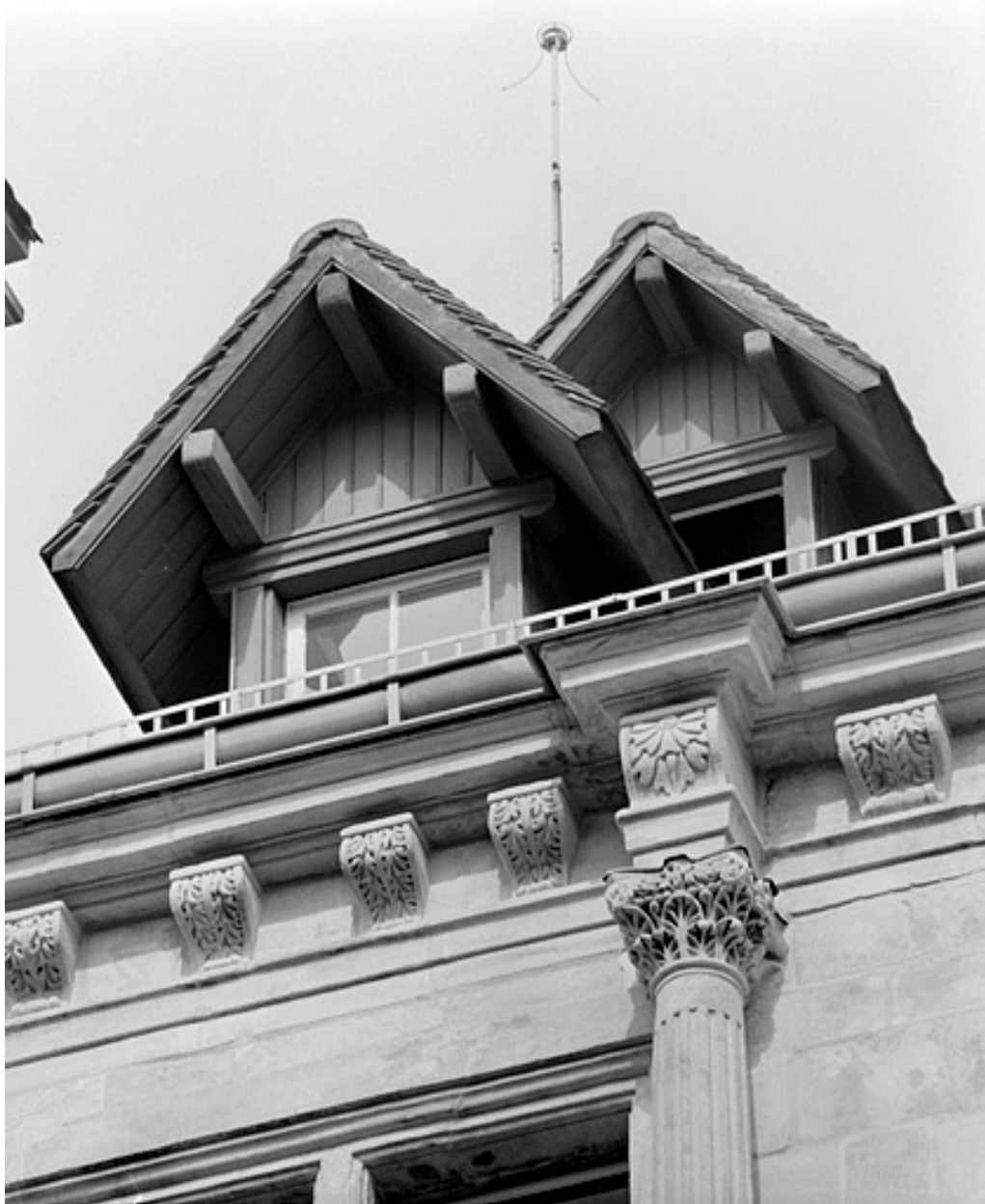
Façade sur la place, troisième étage, détail de l'ordre composite à gauche de la travée centrale.
