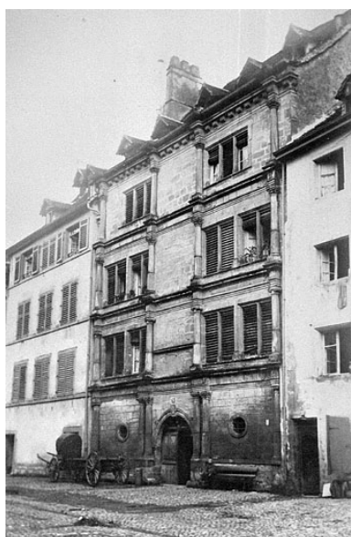
Façade sur la place Saint-Martin [avant la démolition des maisons mitoyennes], vers 1870-1880.
