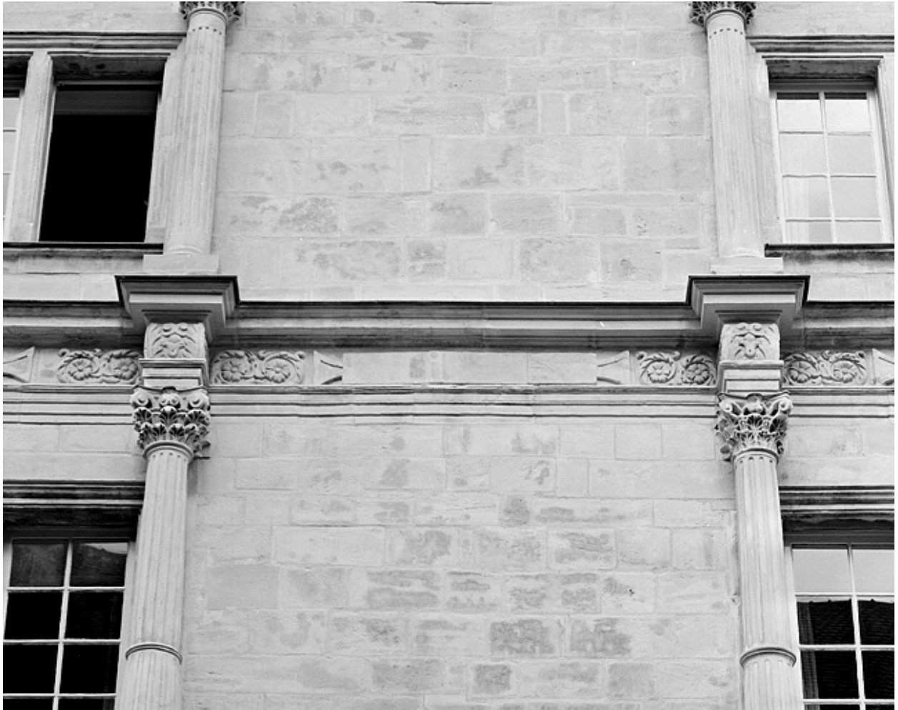
Façade sur la place, deuxième étage, détail de l'ordre corinthien de la travée centrale.
