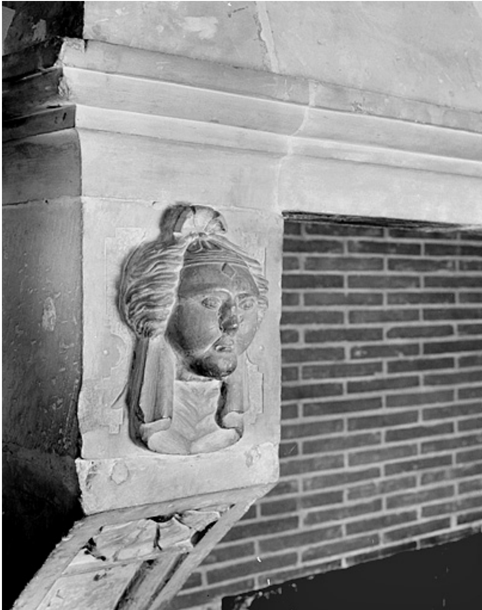
Première cheminée au deuxième étage, détail.
