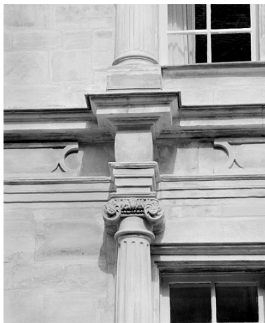
Façade sur la place, premier étage, chapiteau de l'ordre ionique à droite de la travée centrale. Phot. Jérôme Mongreville IVR43_19872500613X
