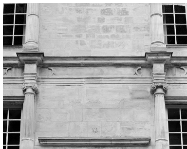
Façade sur la place, premier étage, détail de l'ordre ionique de la travée centrale. Phot. Jérôme Mongreville IVR43_19872500609X
