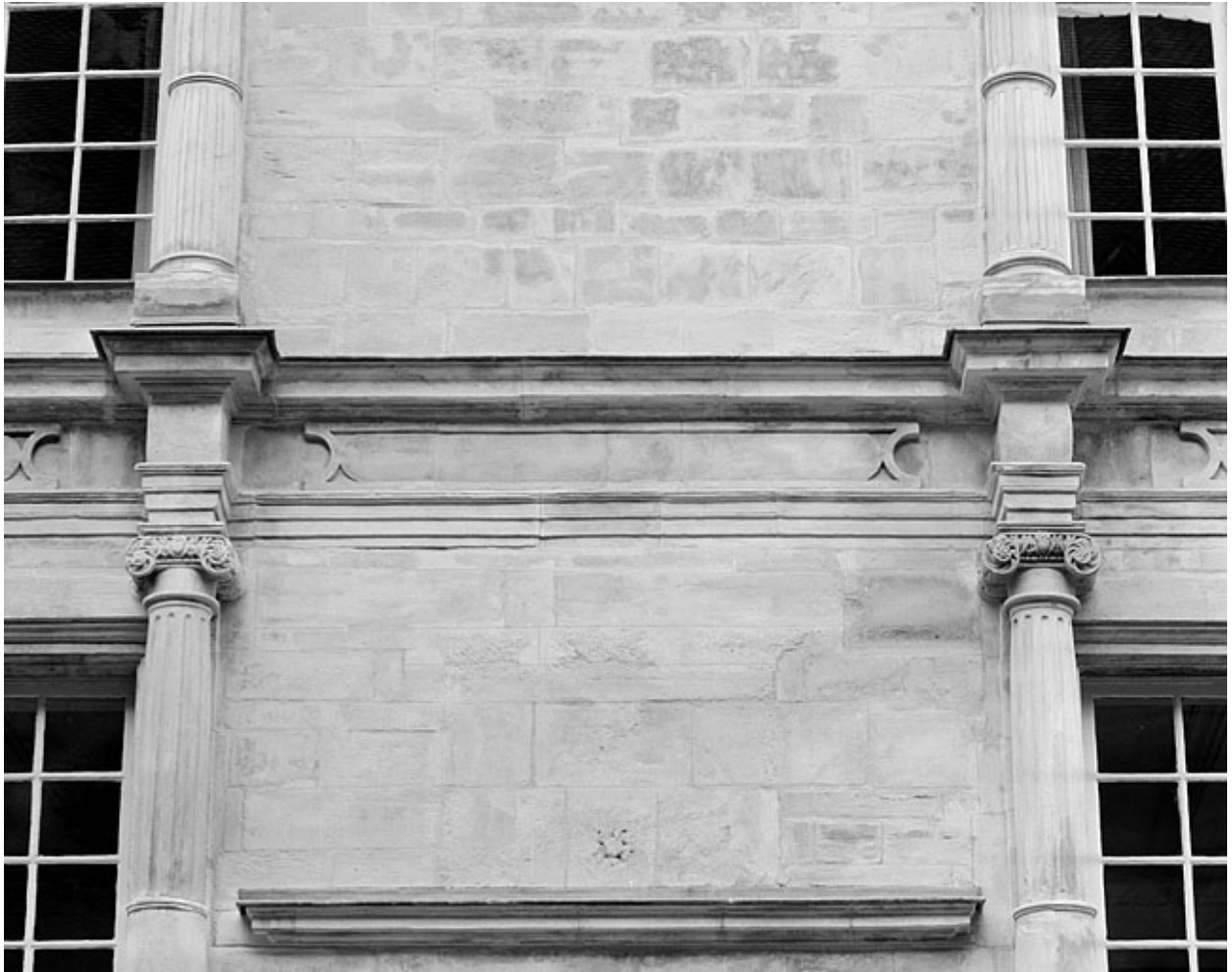
Façade sur la place, premier étage, détail de l'ordre ionique de la travée centrale.
