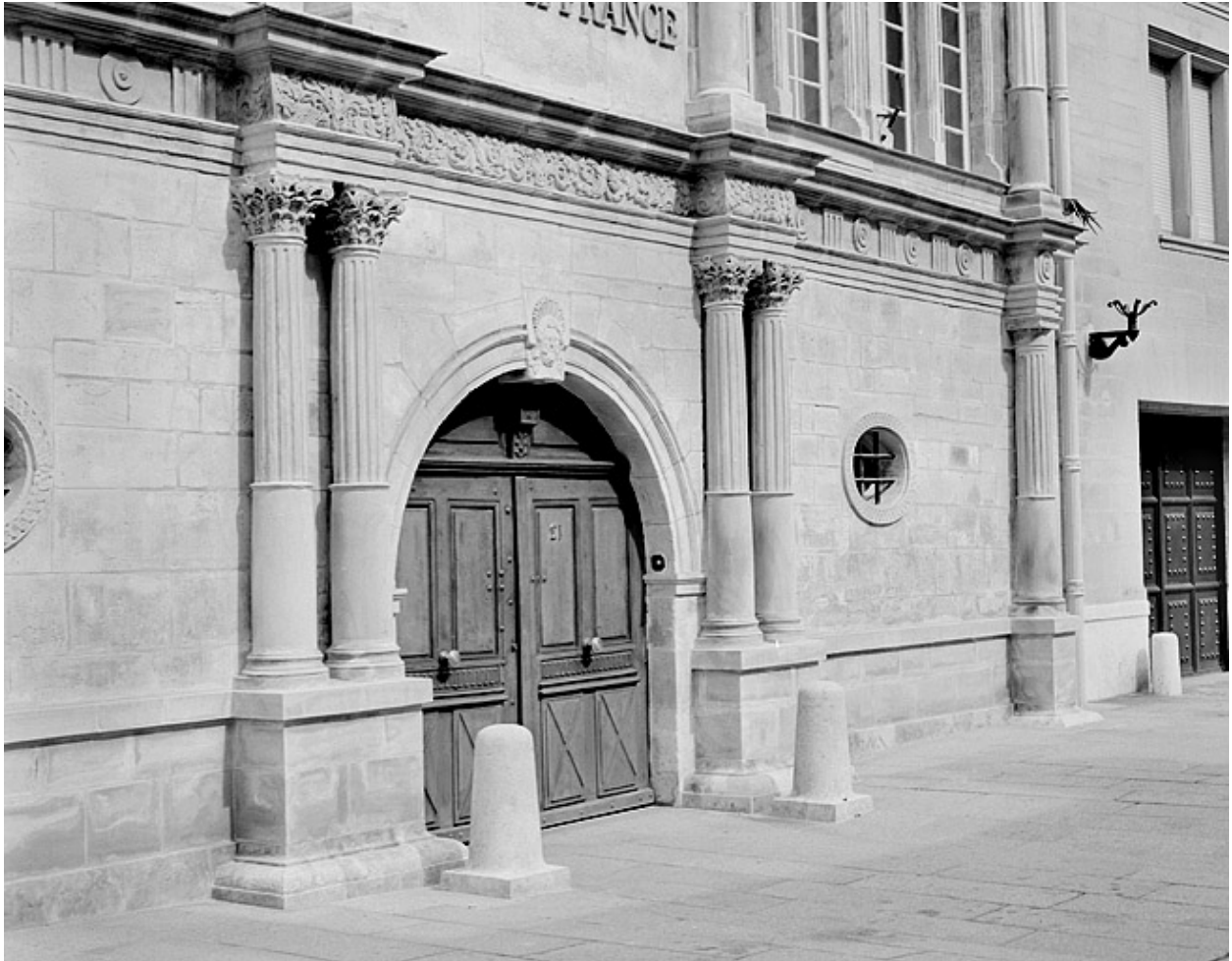
Façade sur la place, rez-de-chaussée.
