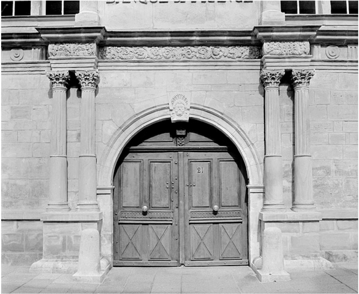
Façade sur la place, portail.
