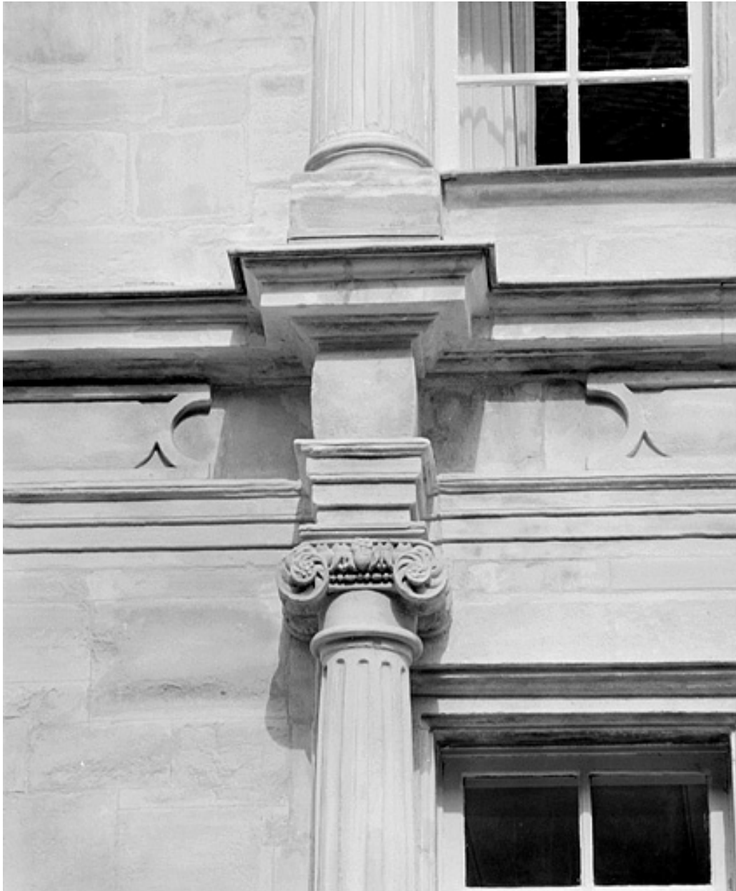
Façade sur la place, premier étage, chapiteau de l'ordre ionique à droite de la travée centrale.
