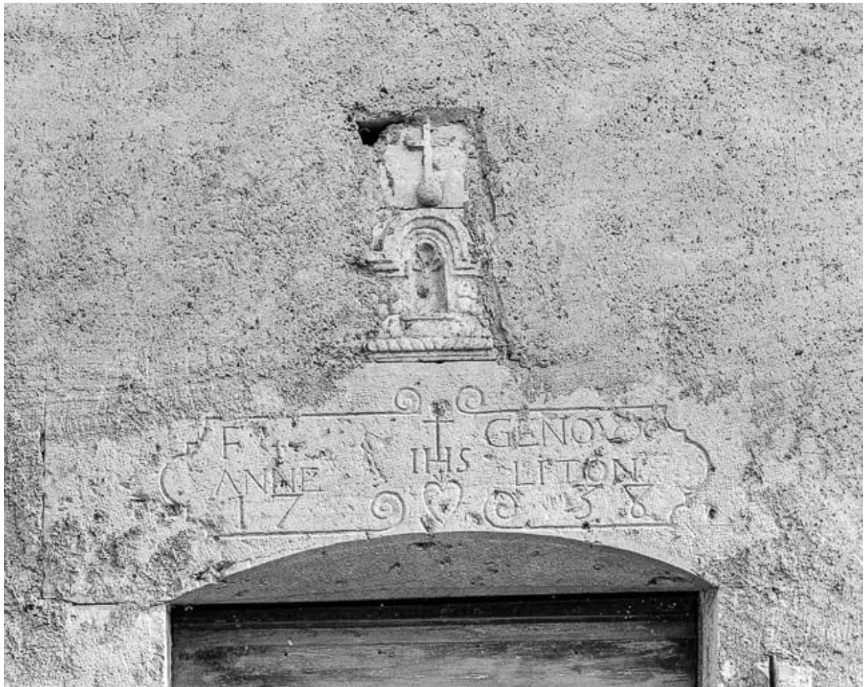
Détail de la porte d'habitation.
