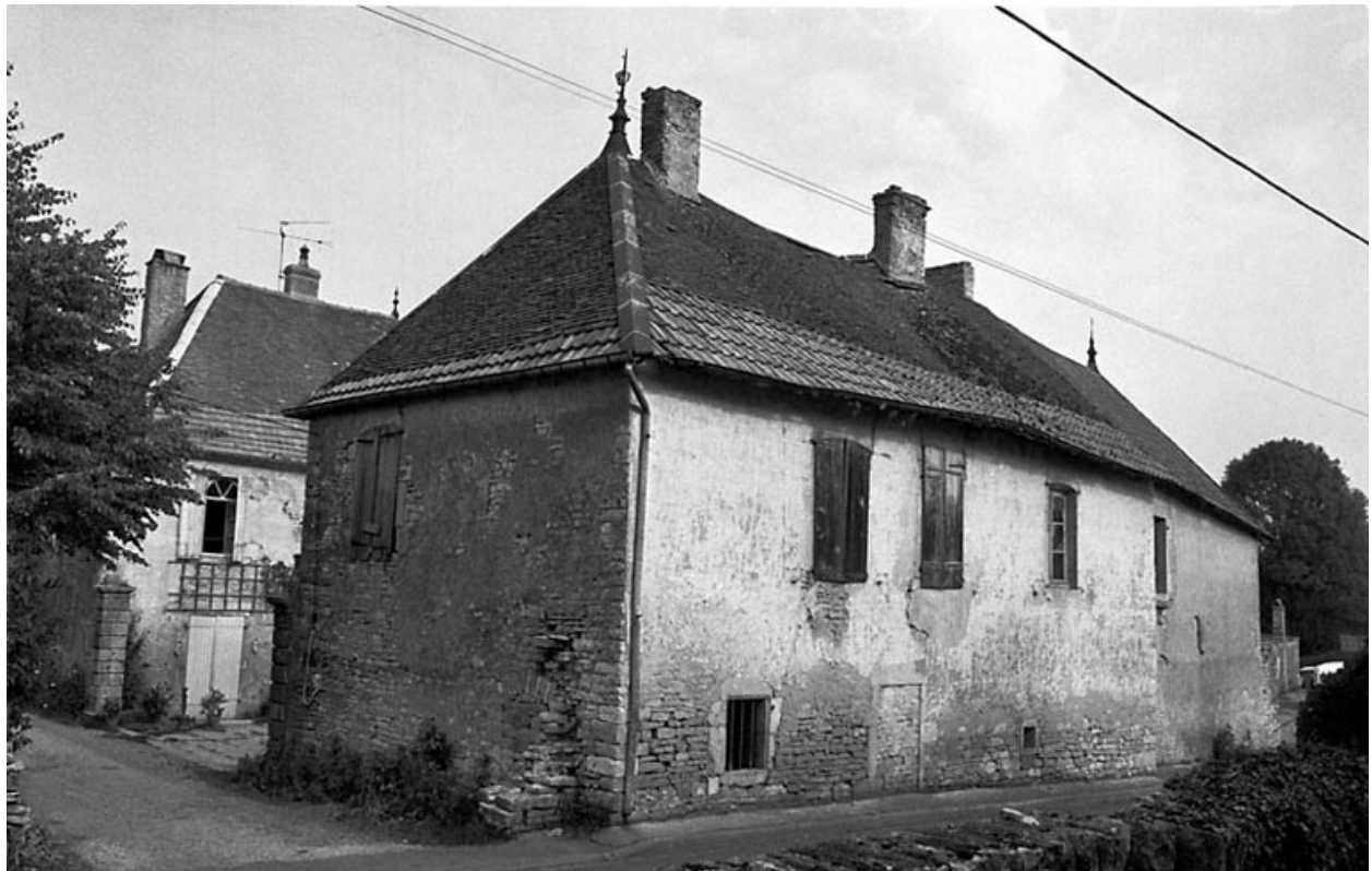
Façade sur rue de l'habitation droite.
