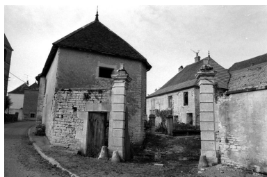
Entrée de la cour de ferme. Phot. Bernard Lardière IVR43_19797000130Z
