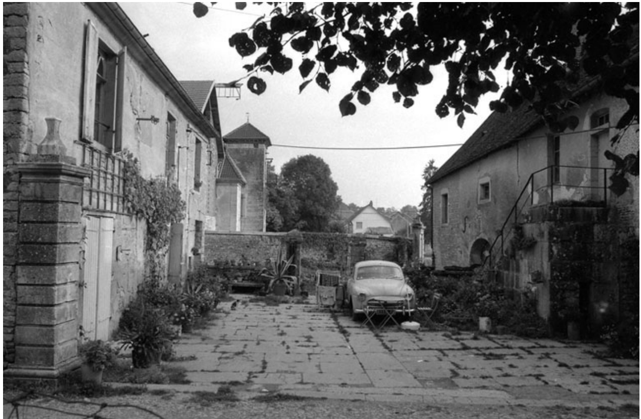
Façades sur cour des deux habitations.
