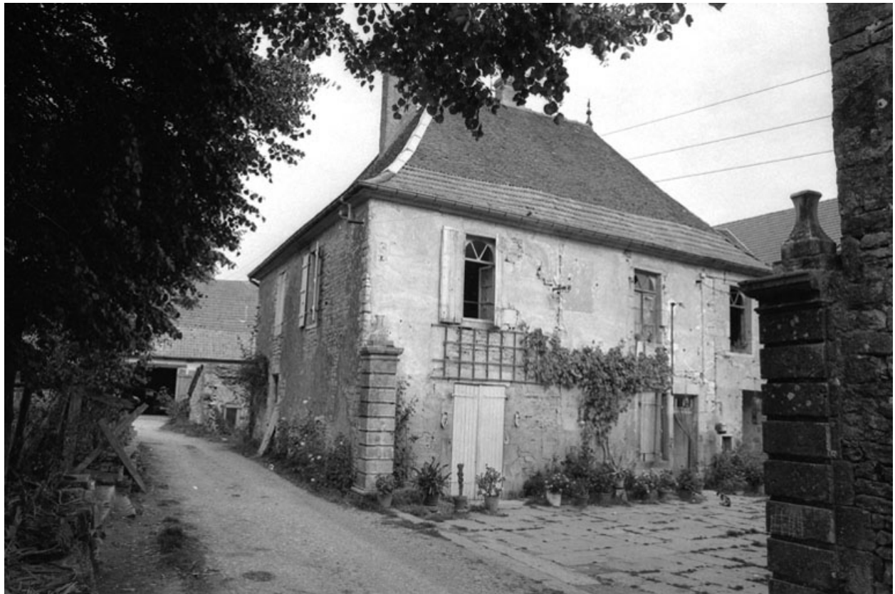
Façade sur cour de l'habitation gauche.
