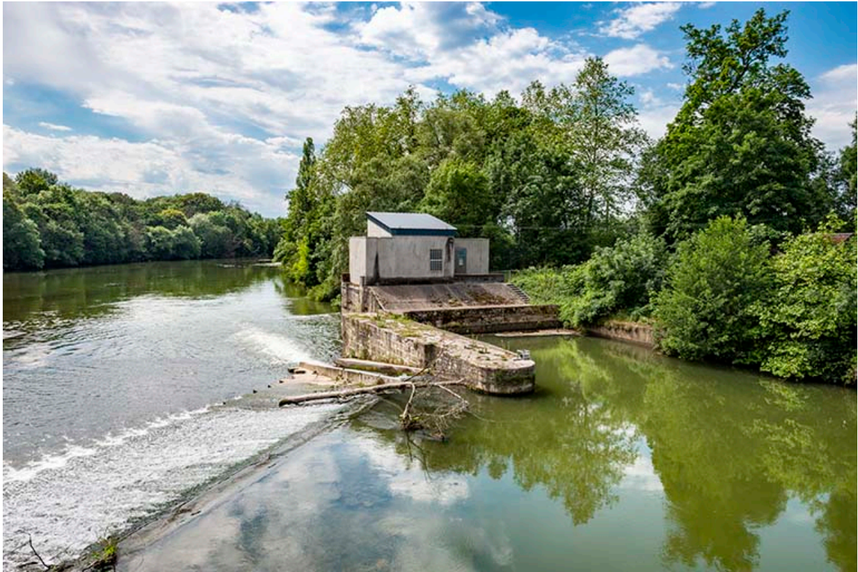
Digue maçonnée où se situait l'ancien pertuis.
