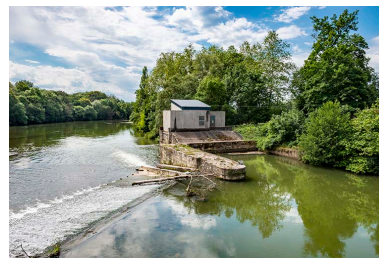
Digue maçonnée où se situait l'ancien pertuis. Phot. Jérôme Mongreville IVR43_20197000395NUC4A
