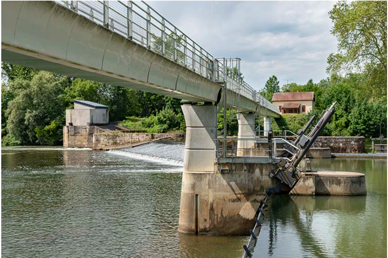
Vue de détail sur les clapets.
