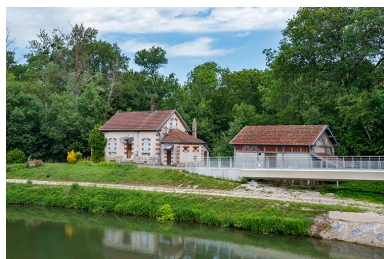
La maison du barragiste, détail. Phot. Jérôme Mongreville IVR43_20197000407NUC4A
