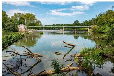
Vue générale depuis l'aval. Phot. Jérôme Mongreville IVR43_20197000406NUC4A
