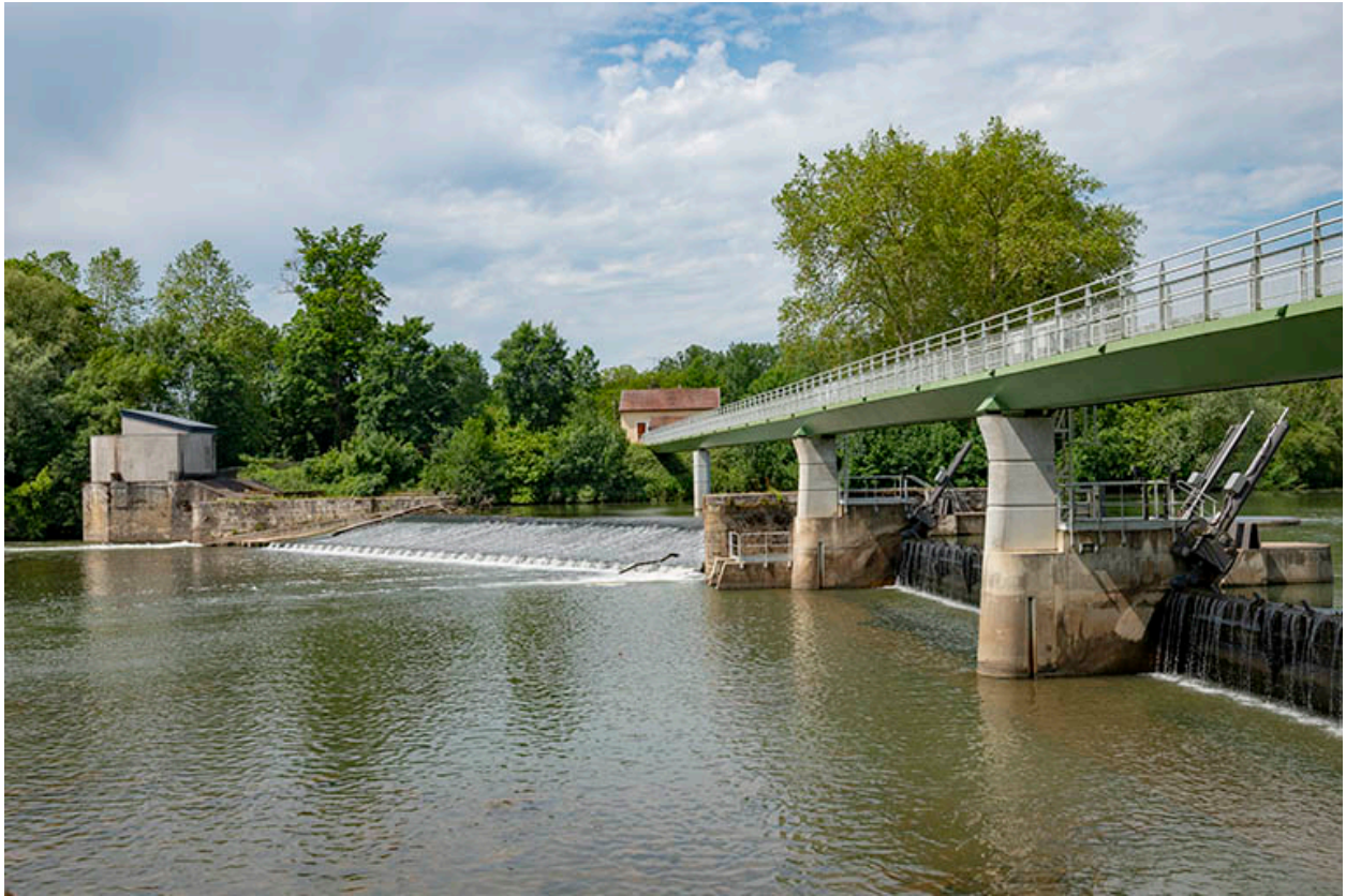
Le barrage mobile et le déversoir, vue générale du site.
