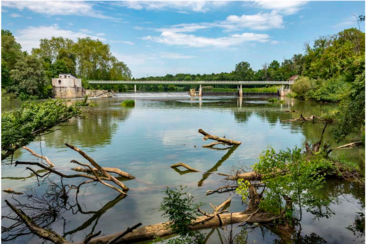
Vue générale depuis l'aval.
