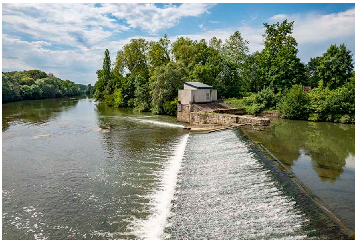
Vue générale sur le déversoir.
