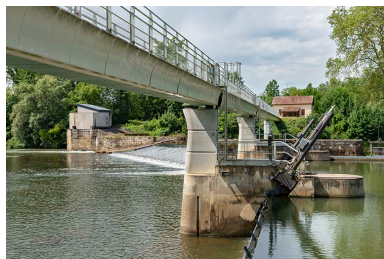
Vue de détail sur les clapets. Phot. Jérôme Mongreville IVR43_20197000403NUC4A
