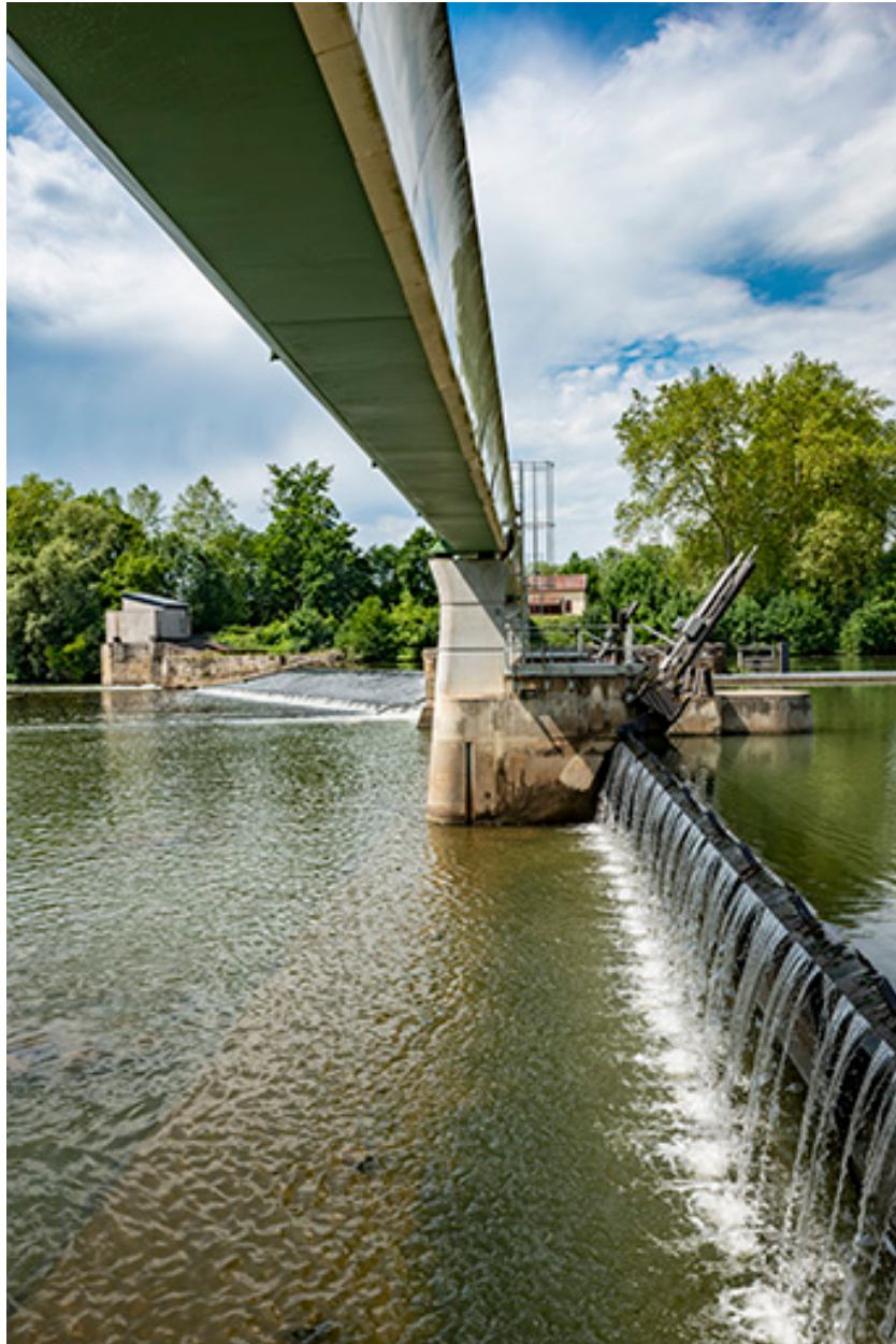
Vue du barrage mobile au premier plan et du déversoir en arrière plan.
