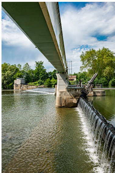
Vue du barrage mobile au premier plan et du déversoir en arrière plan. Phot. Jérôme Mongreville IVR43_20197000404NUC4A
