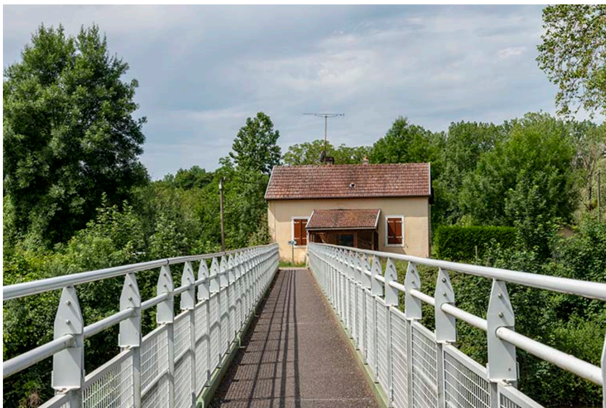
Vue de détail de la passerelle.
