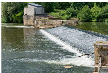
Le déversoir, détail. Phot. Jérôme Mongreville IVR43_20197000400NUC4A
