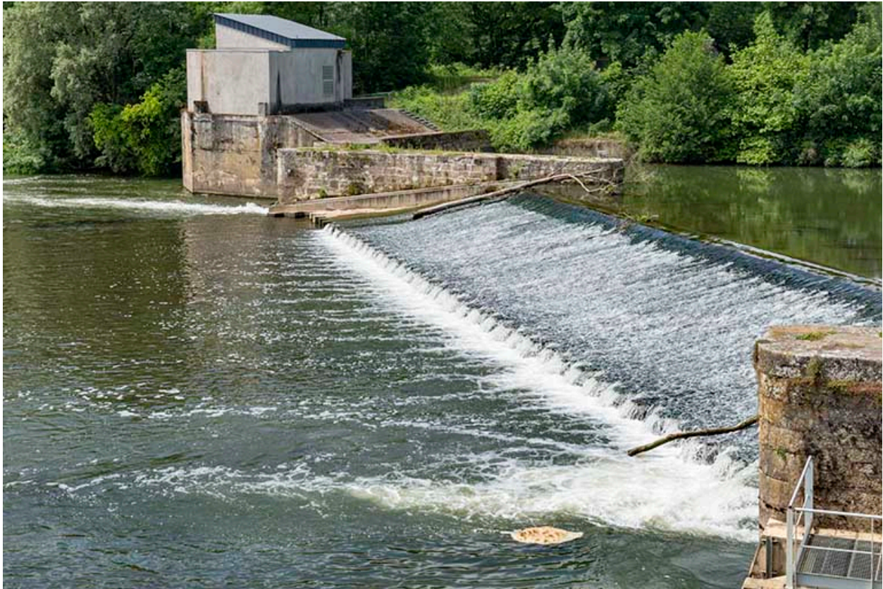
Le déversoir, détail.
