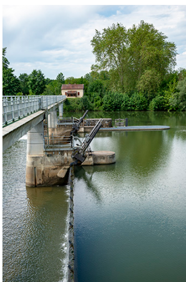
Vue sur le barrage contemporain. Phot. Jérôme Mongreville IVR43_20197000401NUC4A
