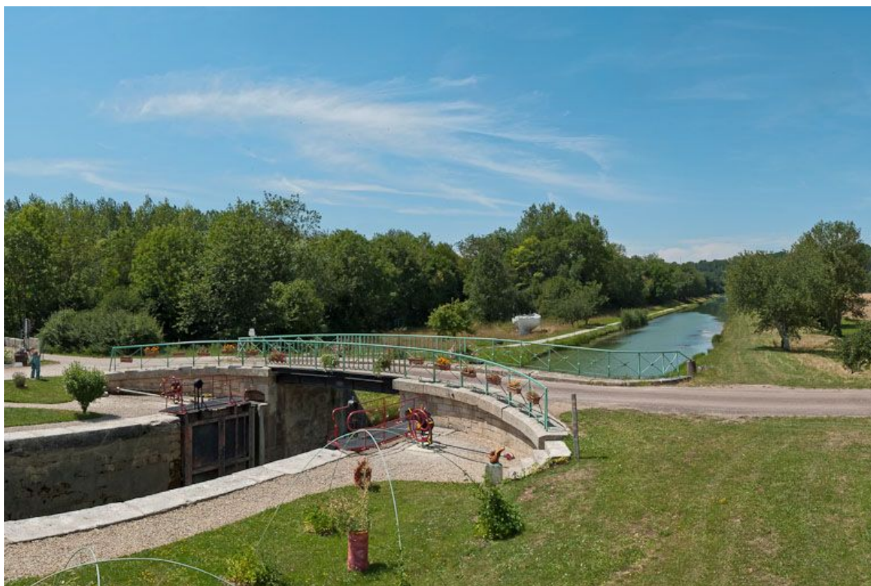
Vue du pont depuis l'amont.
