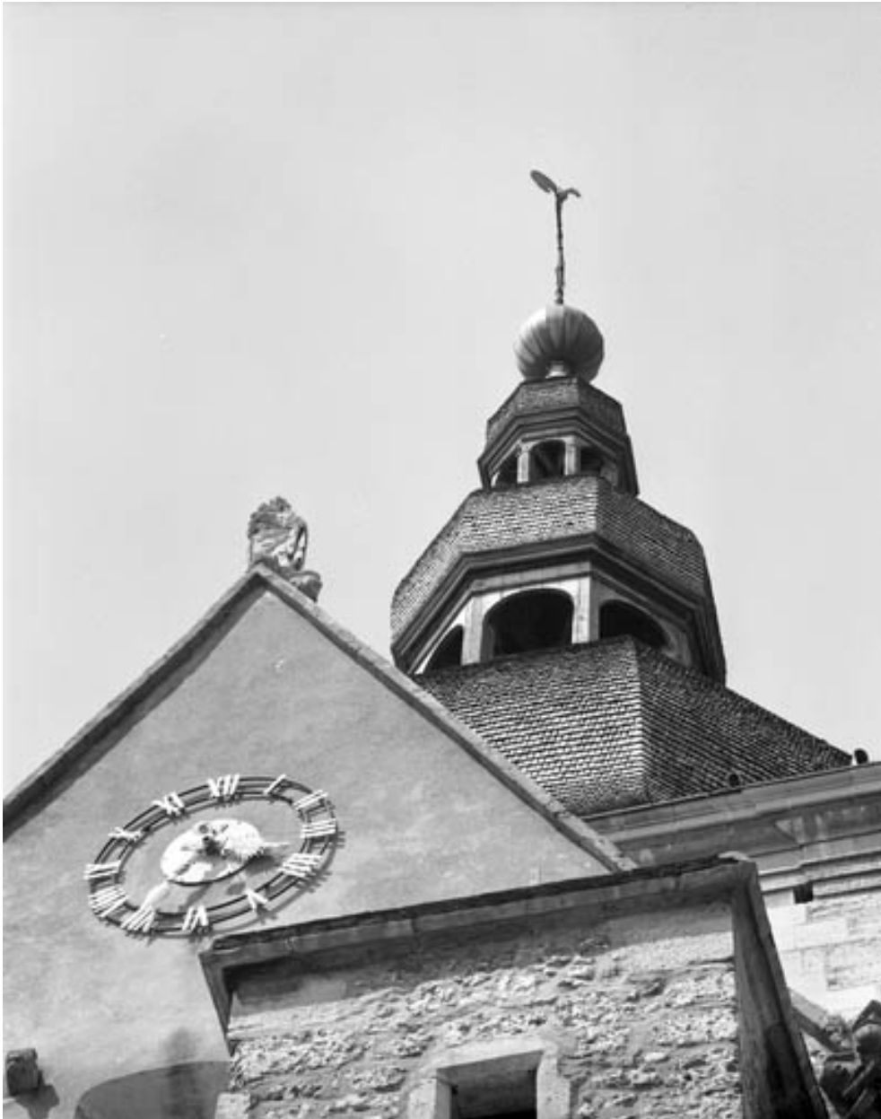
Pignon du bras droit du transept et flèche polygonale du clocher.
