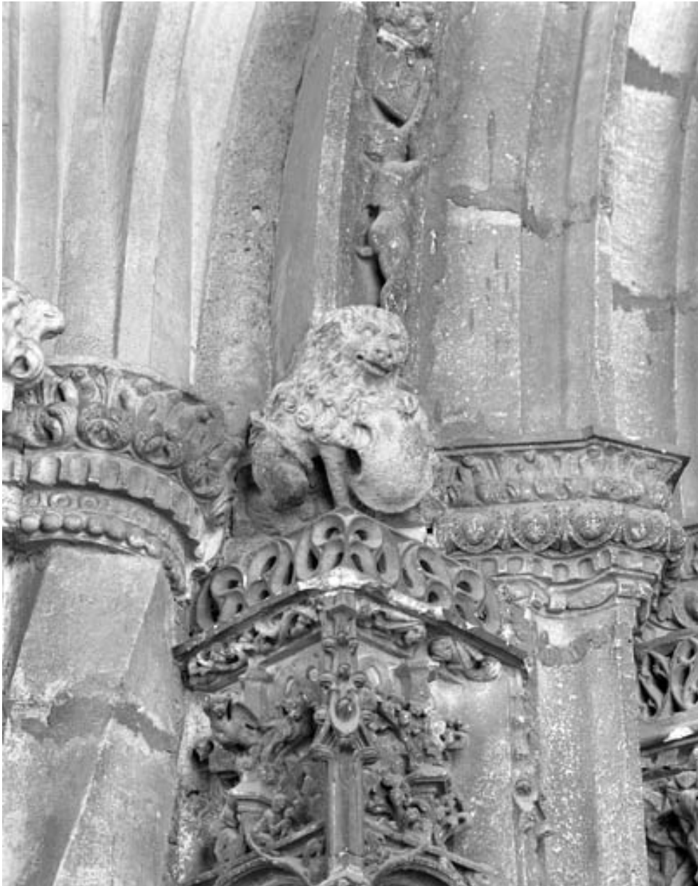
Façade antérieure, portail : porte centrale, détail du départ gauche du premier rouleau de la voussure.
