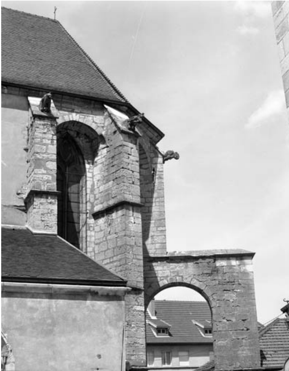
Chevet : détail des contreforts partie droite.
