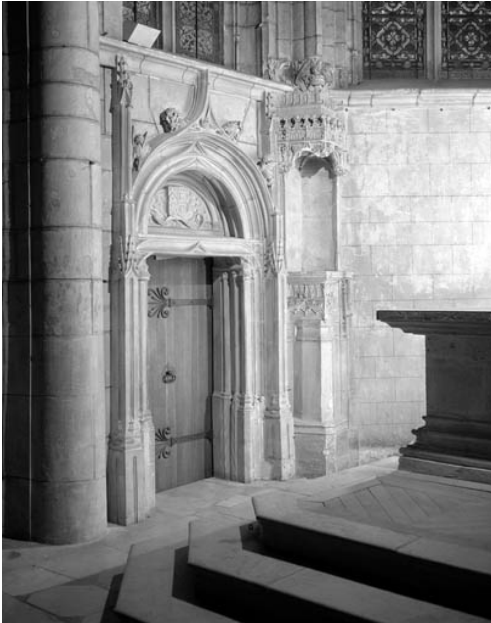
Intérieur : chœur, détail de la porte d'entrée de la sacristie gauche et du tabernacle mural.
