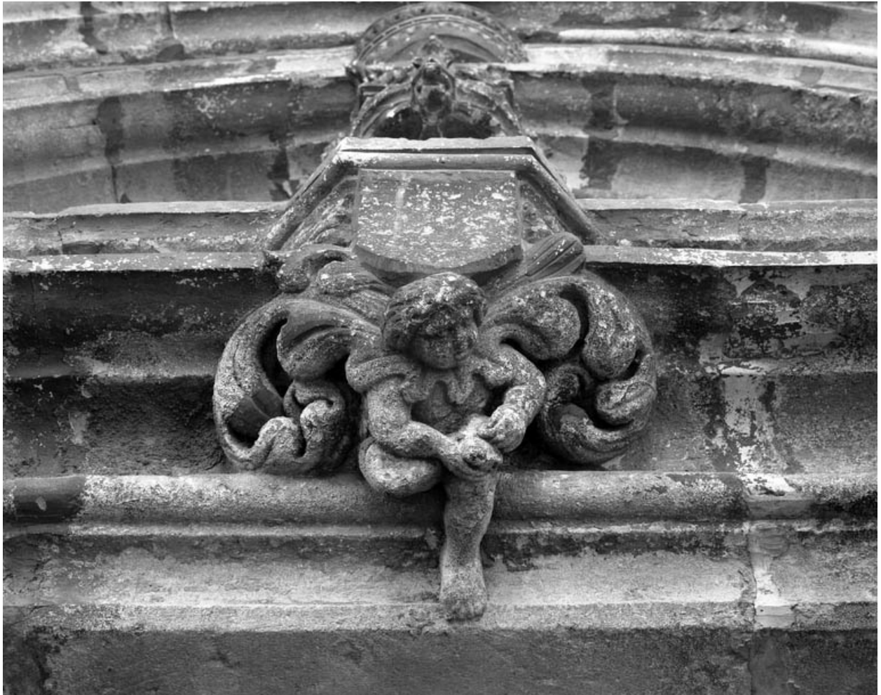
Façade antérieure, portail : détail de la sculpture au centre du linteau de la porte d'entrée droite.
