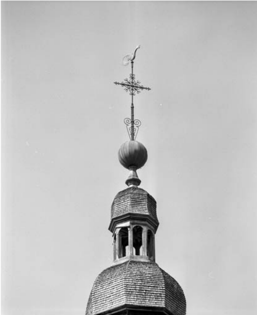
Tour-clocher : détail du lanternon.
