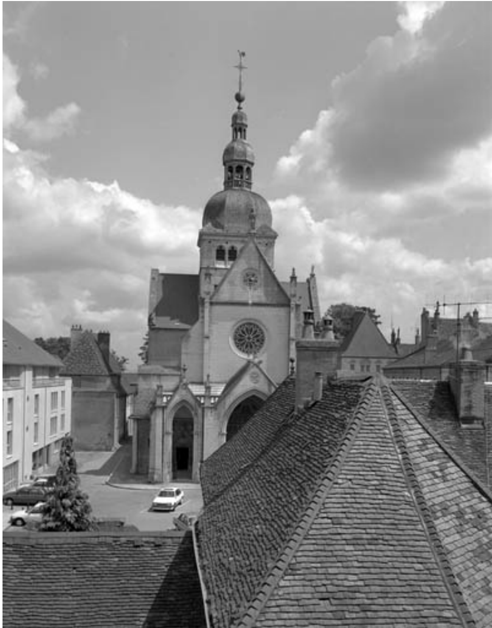
Vue de la façade antérieure depuis l'ancien couvent des Annonciades.
