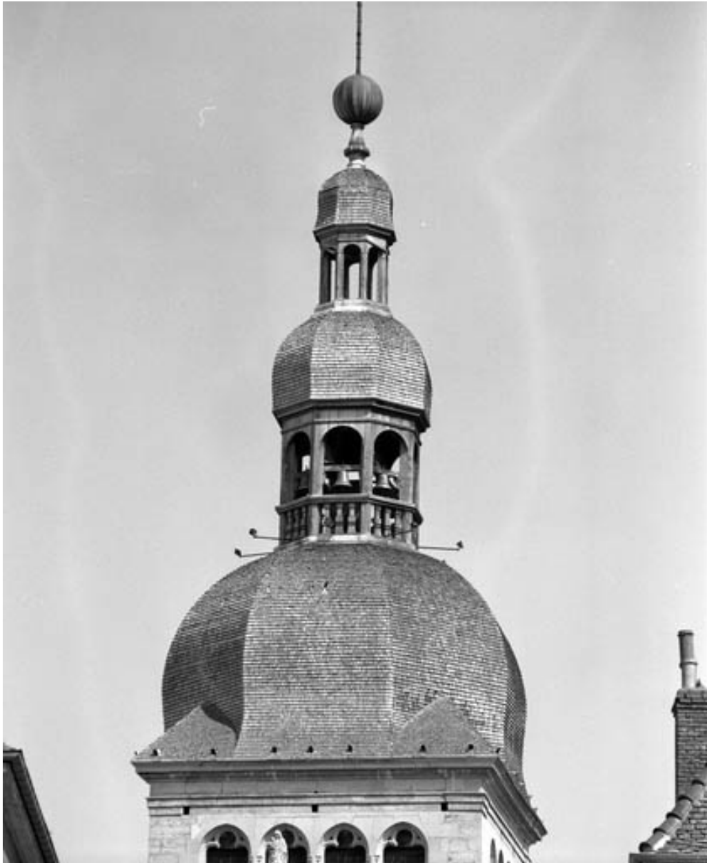
Tour-clocher : détail du bulbe et du lanternon.
