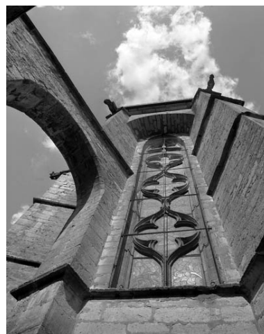
Chevet : détail d'une baie. Phot. Yves Sancey IVR43_19897000160X
