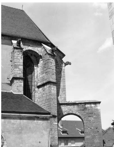
Chevet : détail des contreforts partie droite. Phot. Yves Sancey IVR43_19897000158X
