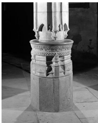
Intérieur : détail de la base d'une colonne de la première travée de la nef formant un bénitier.
