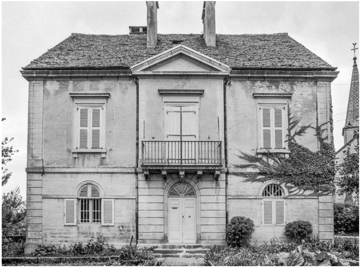
Façade antérieure vue rapprochée de face.
