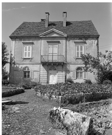
Façade antérieure et jardin. Phot. Yves Sancey IVR43_19793900103X
