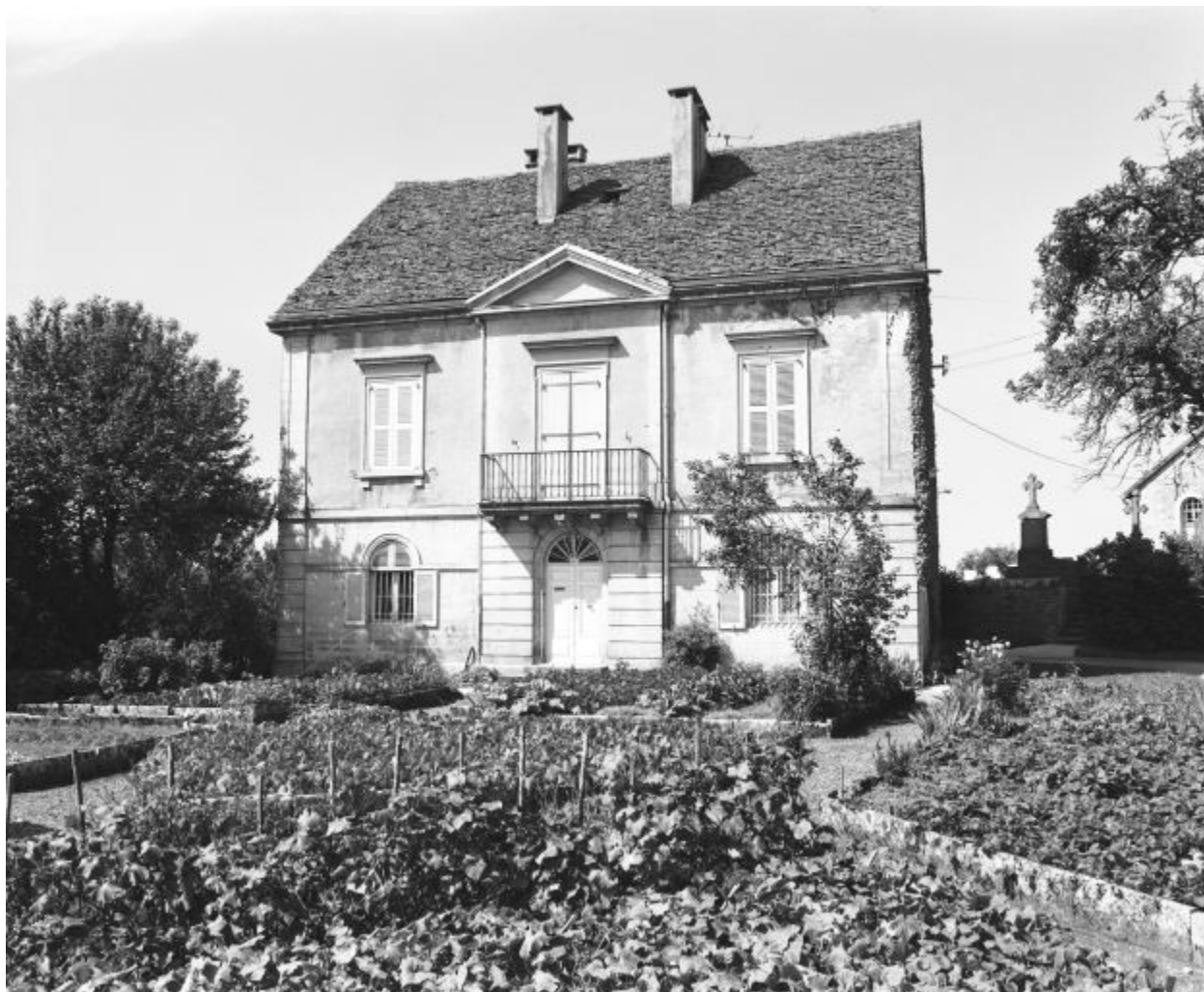
Façade antérieure vue de face.
