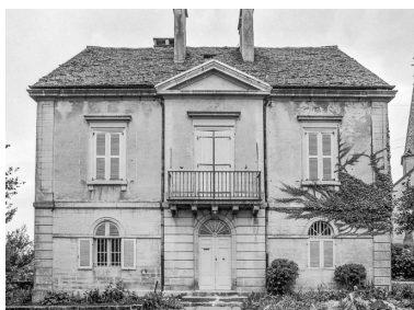
Façade antérieure vue rapprochée de face. Phot. Bernard Pontefract IVR43_19763900267Z
