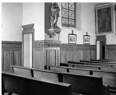
Vue d'ensemble côté nord. Phot. Yves Sancey IVR43_20002500080X
