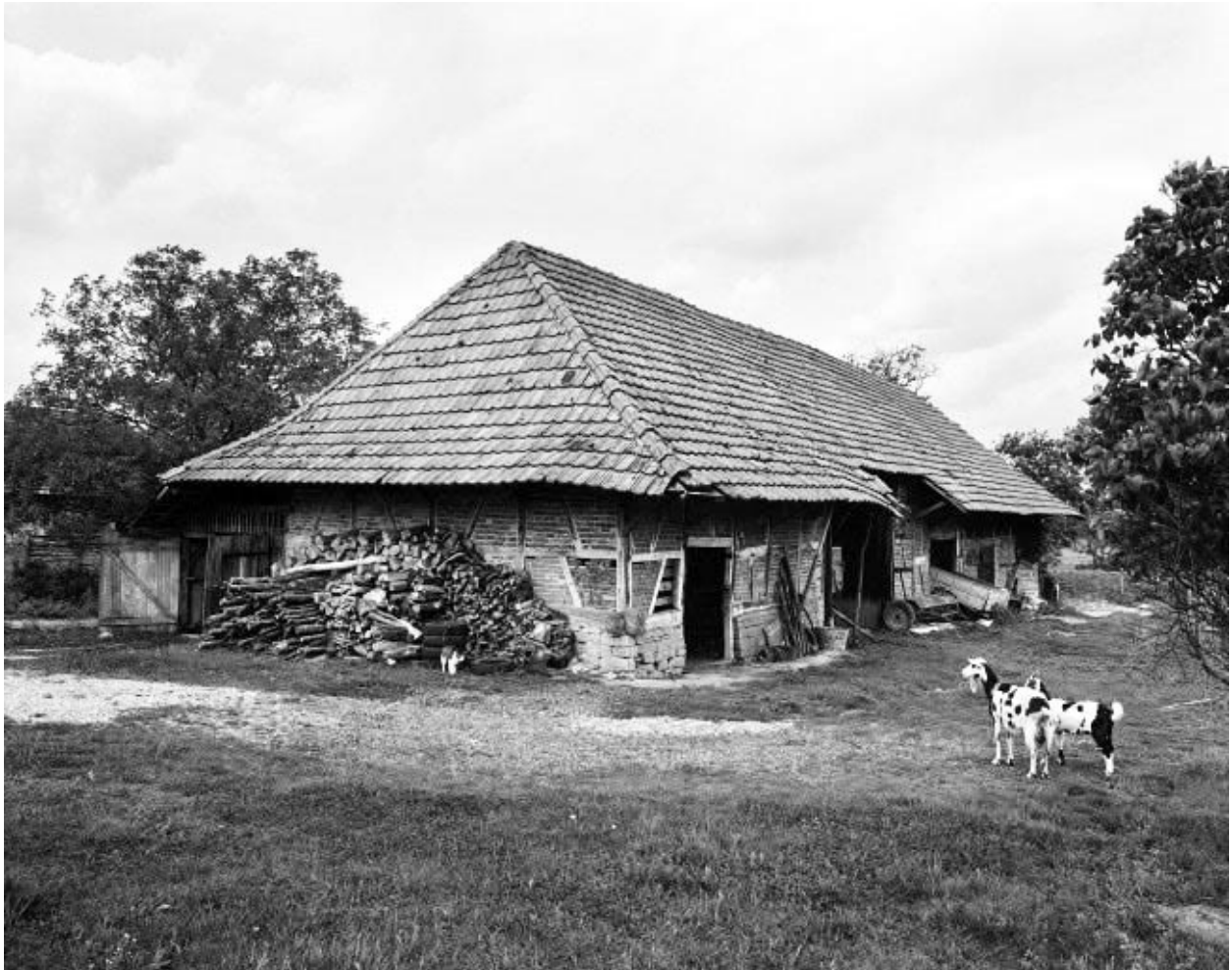
Bâtiment d'exploitation : façades antérieure et latérale gauche.
