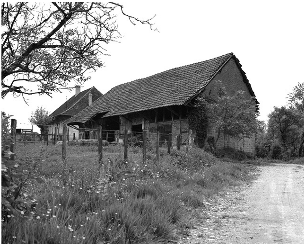
Bâtiment d'exploitation : façades antérieure et latérale droite.
