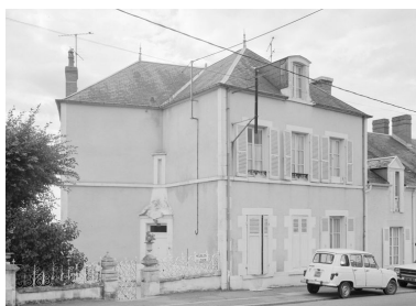
Élévation sur l'actuelle avenue du Général d'Espeuilles en 1978. Phot. Michel Rosso IVR26_19785800231V
