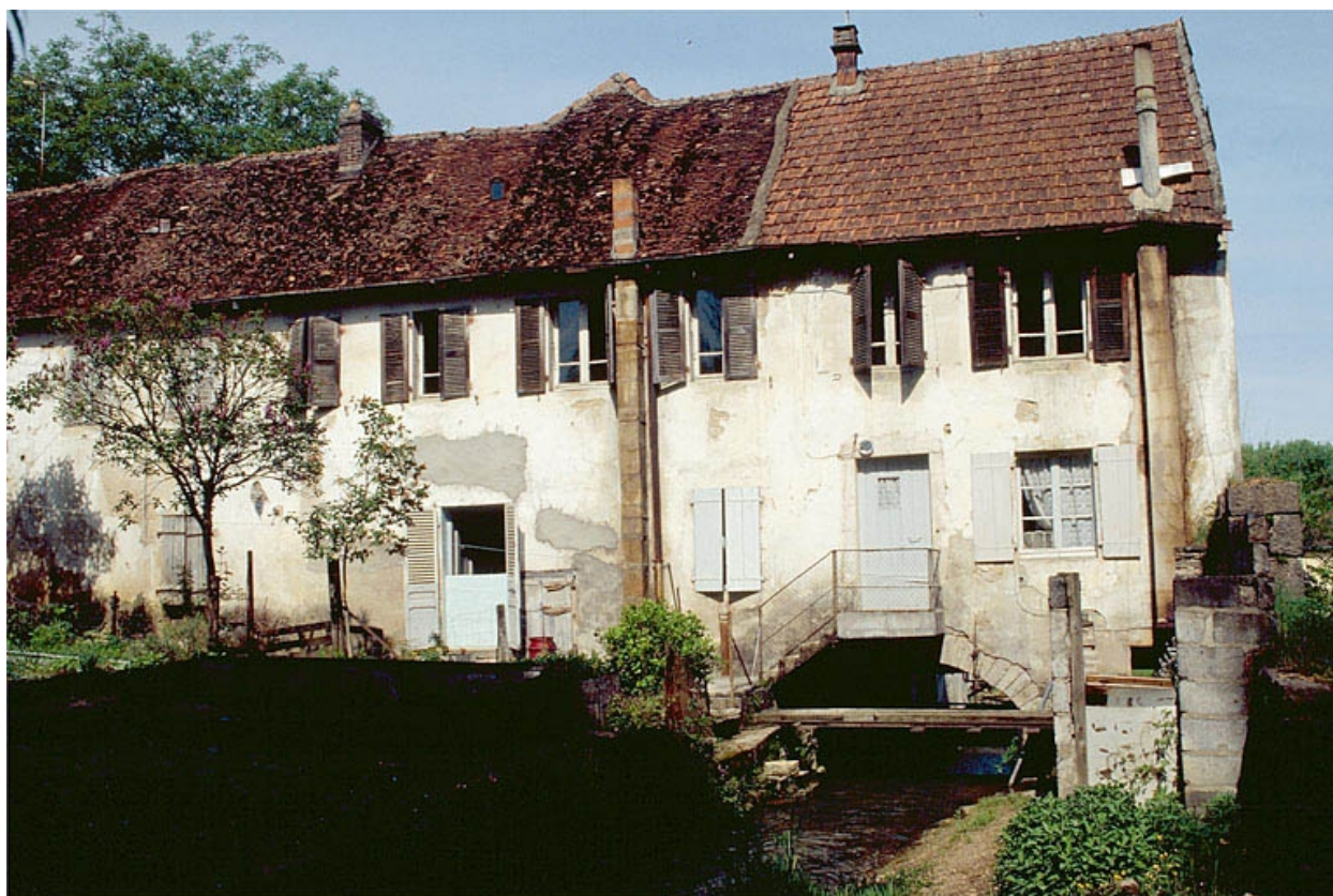
Bâtiment d'eau et logement depuis le sud-est.
