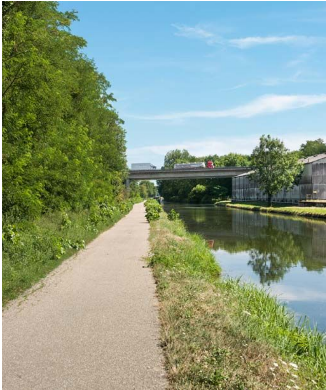
Vue d'ensemble du pont.
