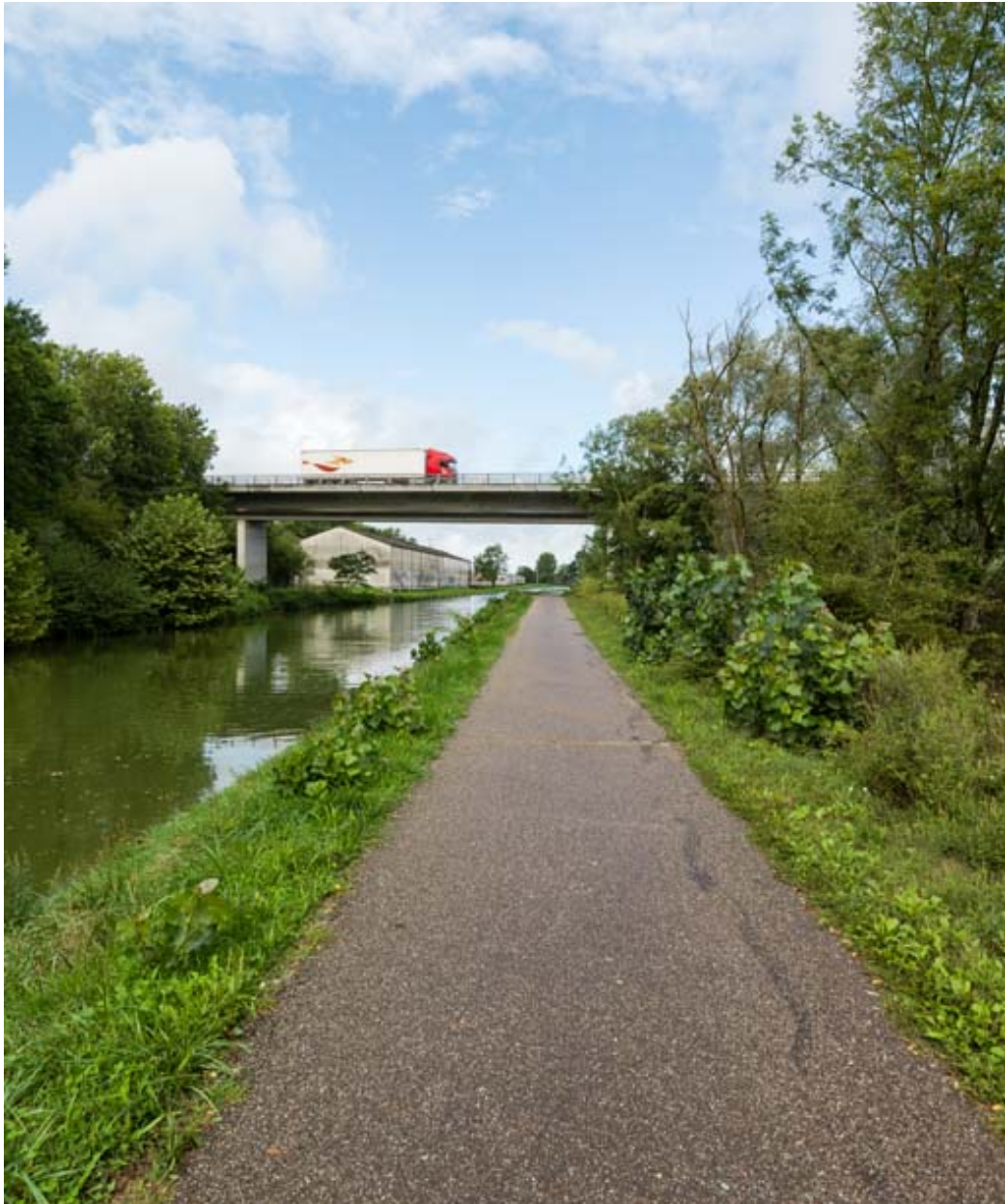
Vue d'ensemble du pont.
