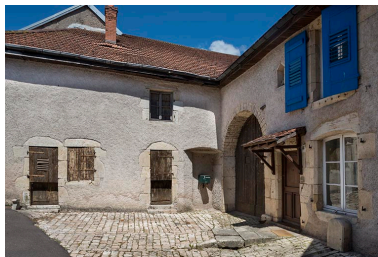
Façade antérieure, partie nord. Phot. Jérôme Mongreville IVR43_20187000328NUC4A
