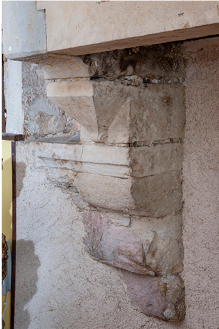
Console supportant la cheminée.
