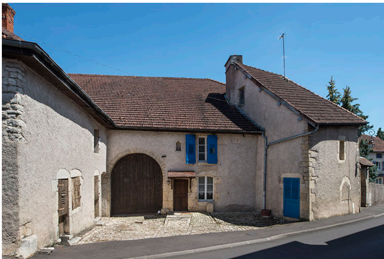
La façade antérieure et la cour.
