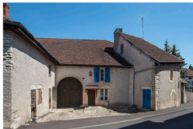
La façade antérieure et la cour. Phot. Jérôme Mongreville IVR43_20187000327NUC4A
