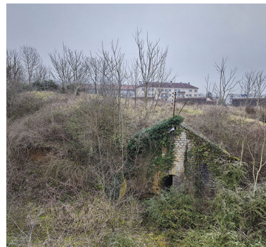
Entrée de la poudrière. (vue aérienne). Phot. Nicolas Douriaux IVR26_20262100323NUC4A
