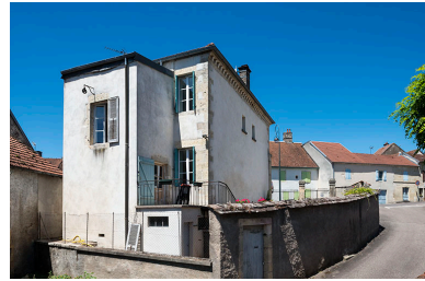
Façade postérieure. Phot. Jérôme Mongreville IVR43_20187000333NUC4A
