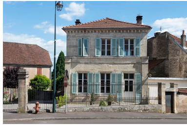
La façade antérieure. Phot. Jérôme Mongreville IVR43_20187000337NUC4A
