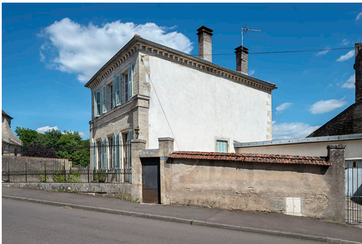
Le mur pignon sud-ouest.
