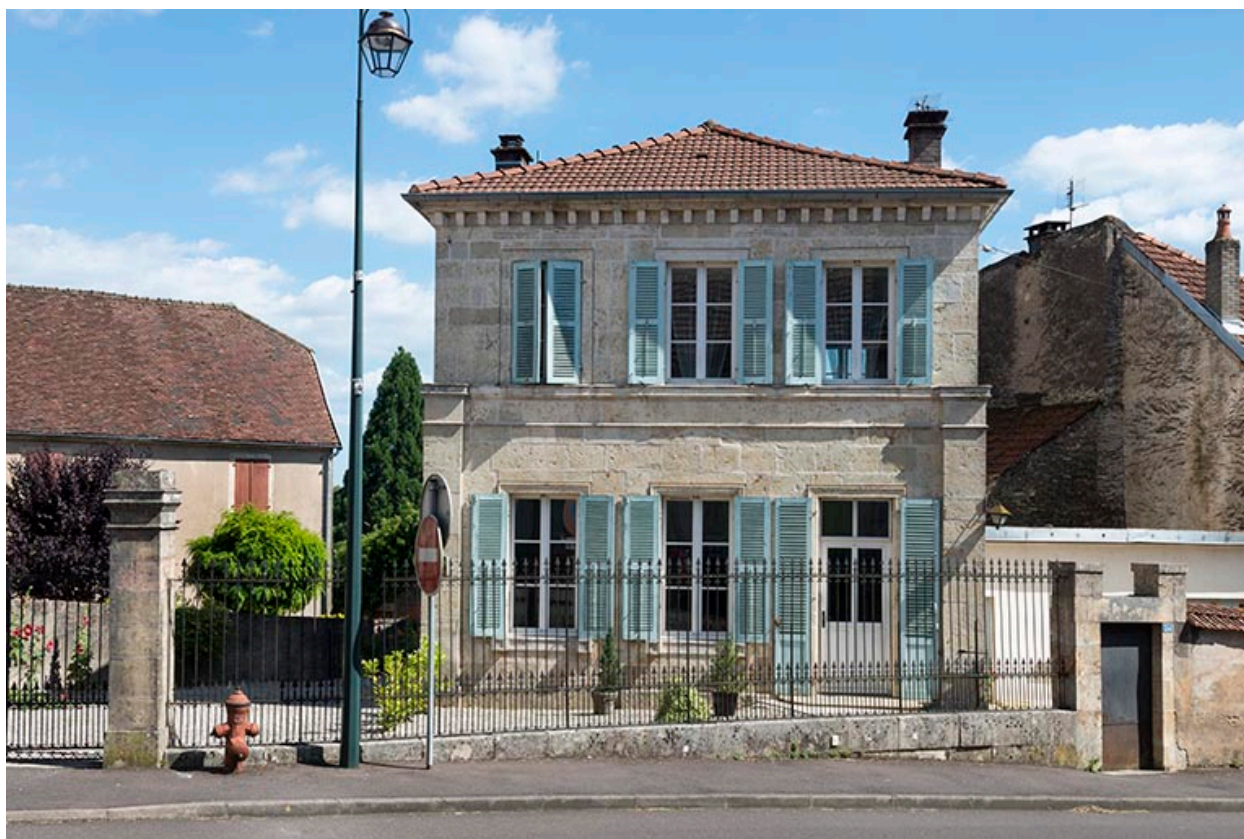
La façade antérieure.
