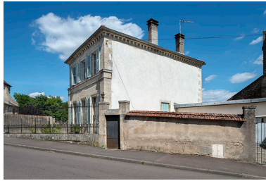
Le mur pignon sud-ouest. Phot. Jérôme Mongreville IVR43_20187000335NUC4A
