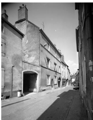
Façade antérieure de trois quarts gauche. Phot. Yves Sancey IVR43_19897000157V
