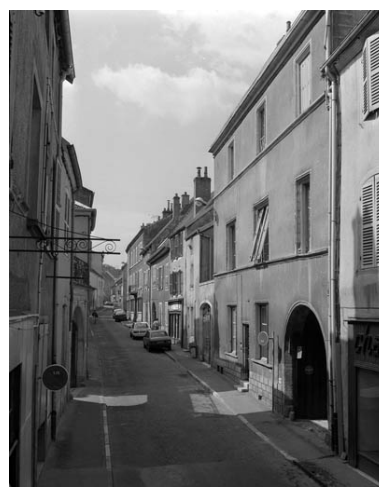
Façade antérieure, de trois quarts droit. Phot. Yves Sancey IVR43_19917000123X
