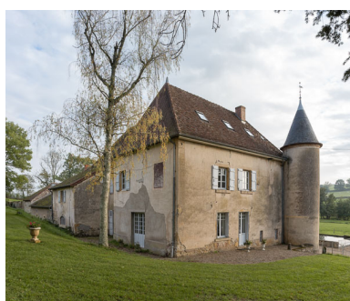
Vue des façades latérale ouest et postérieure du château (fin du XVIIIe siècle), avec une des tours d'angle de la façade antérieure du XIXe siècle. Phot. Pierre-Marie Barbe-Richaud IVR26_20197100433NUC4A
