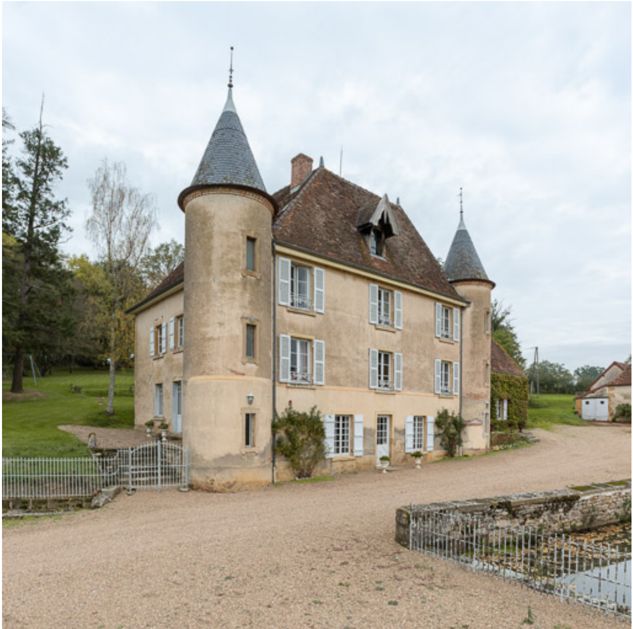
Vue de la façade antérieure du château, construite dans la deuxième moitié du XIXe siècle devant l'ancien corps de logis (fin du XVIIIe siècle).
