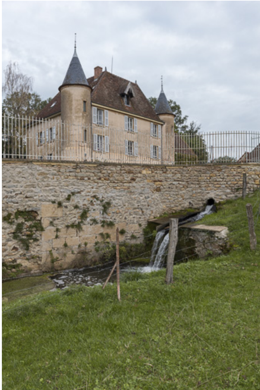
Emplacement de l'ancienne roue à aubes du moulin Gaillot, actionnée grâce au bief, alimenté par le ruisseau de la Belaine
