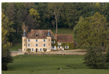
Vue de la façade antérieure de la demeure, dite "château d'Essiat", à Sarry Phot. Pierre-Marie Barbe-Richaud IVR26_20197100437NUC4A
