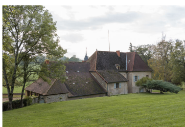
Façade postérieure du château : de gauche à droite, les bâtiments d'origine de la meunerie, en partie conservés, et la maison de maître de la fin du XVIIIe siècle avec ses toits à croupes. Phot. Pierre-Marie Barbe-Richaud IVR26_20197100431NUC4A
