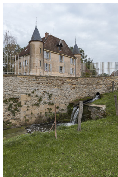
Emplacement de l'ancienne roue à aubes du moulin Gaillot, actionnée grâce au bief, alimenté par le ruisseau de la Belaine Phot. Pierre-Marie Barbe-Richaud IVR26_20197100426NUC4A
