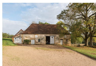
Façade antérieure de la grange Phot. Pierre-Marie Barbe-Richaud IVR26_20197100434NUC4A
