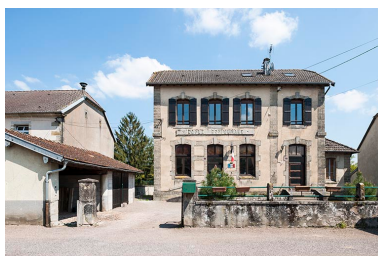
Vue générale. Phot. Jérôme Mongreville IVR43_20167000376NUC4A
