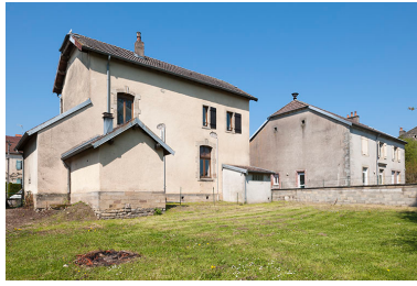
Façade postérieure. Phot. Jérôme Mongreville IVR43_20167000350NUC4A
