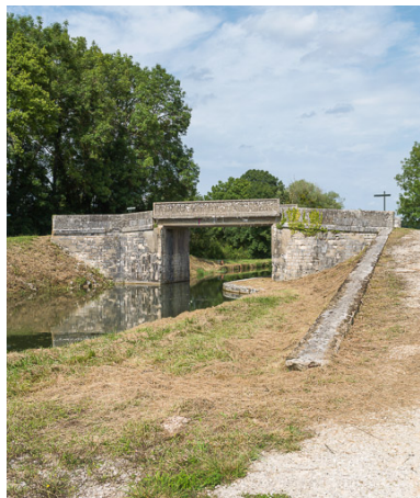
Vue du pont.
