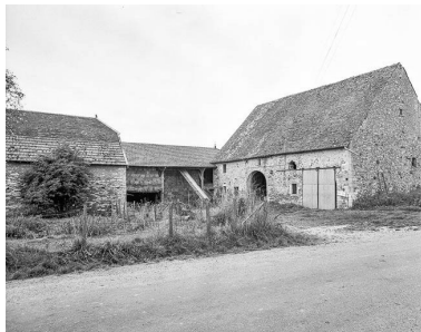
Façades sur cour. Phot. Dominique Dominguez
