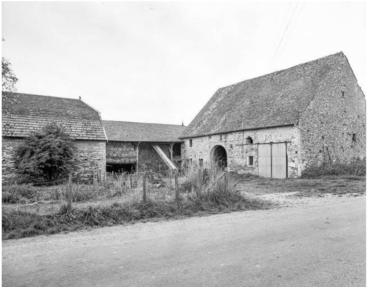
Façades sur cour.
