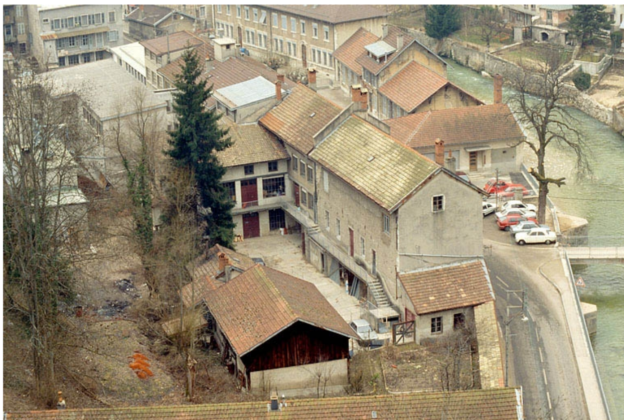
Façades postérieures et latérales gauches.
