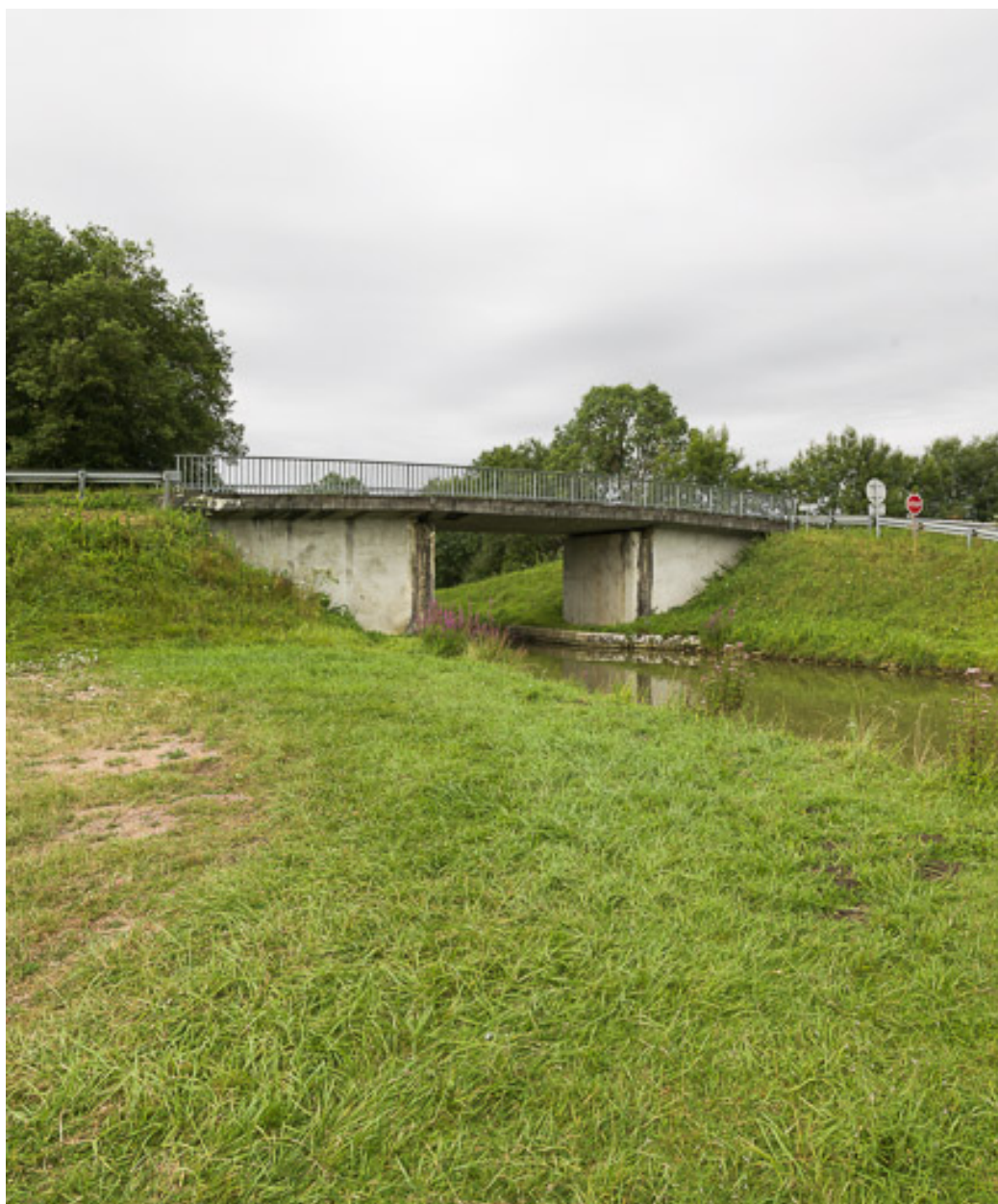
Vue d'ensemble du pont.
