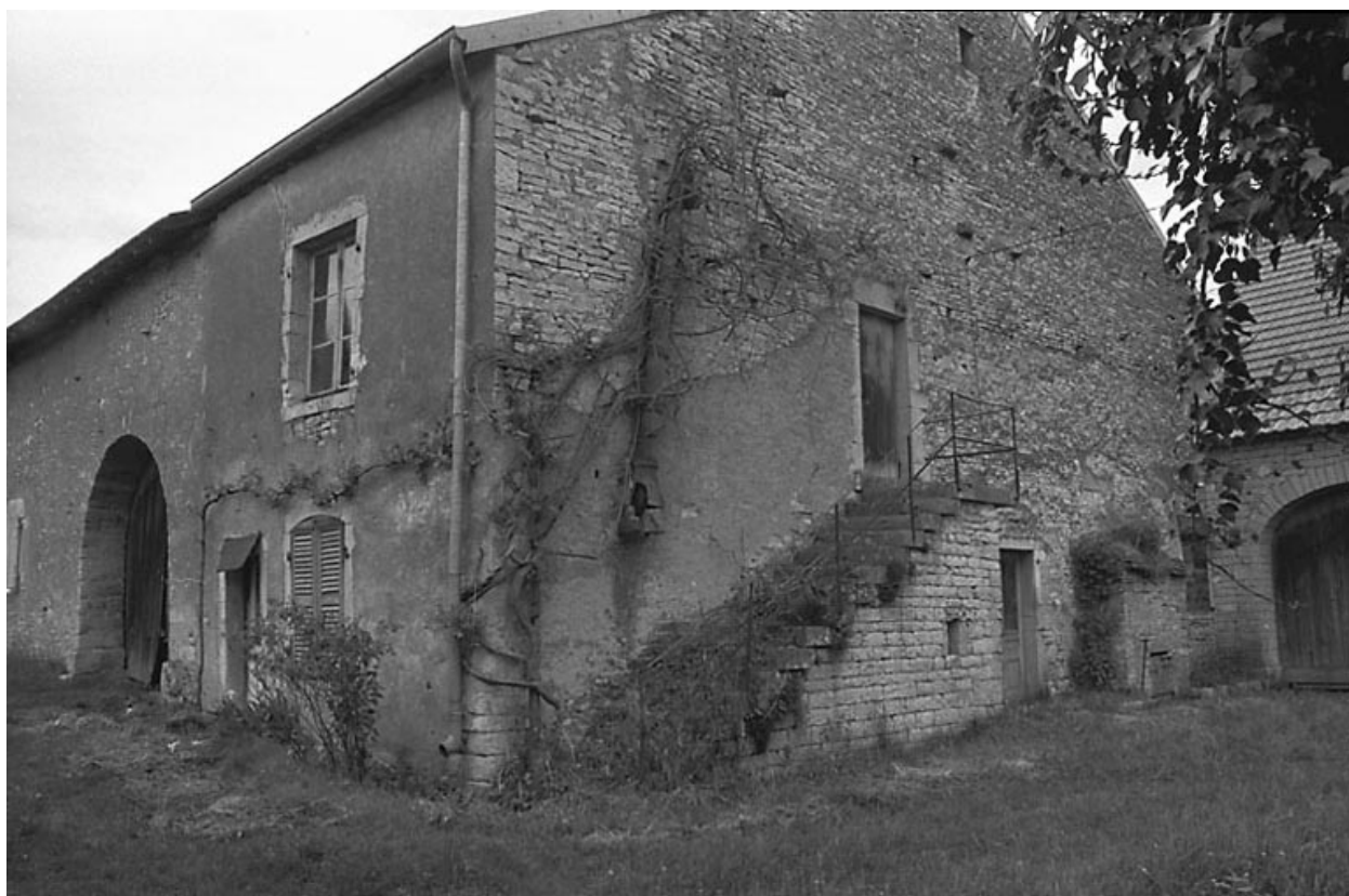
Vue de l'habitation.
