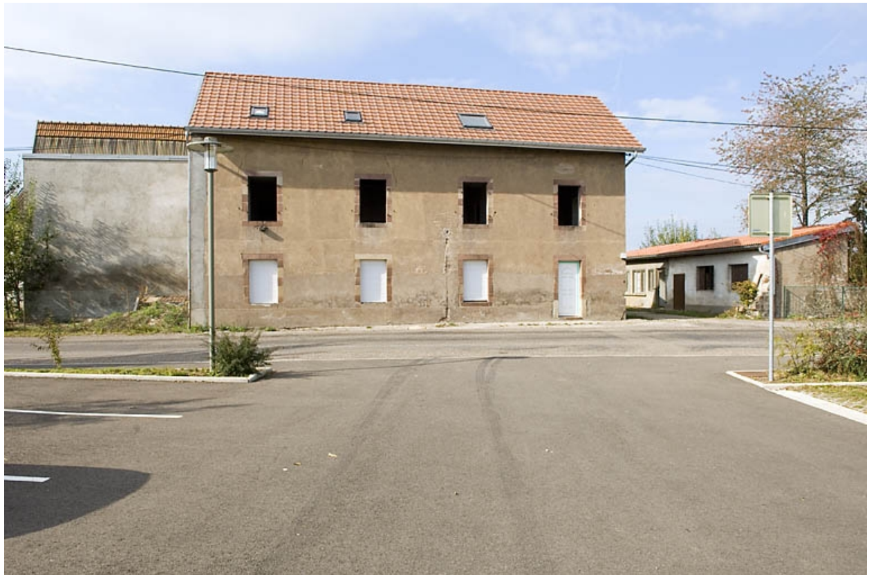
Ancien atelier de fabrication (?). Façade sur rue.
