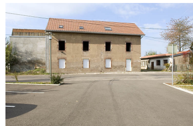
Ancien atelier de fabrication (?). Façade sur rue. Phot. Jérôme Mongreville IVR43_20077000664NUCA
