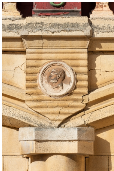
Bas-relief sur l'élévation antérieure de la maison. Phot. Pierre-Marie Barbe-Richaud IVR26_20222100884NUC4A
