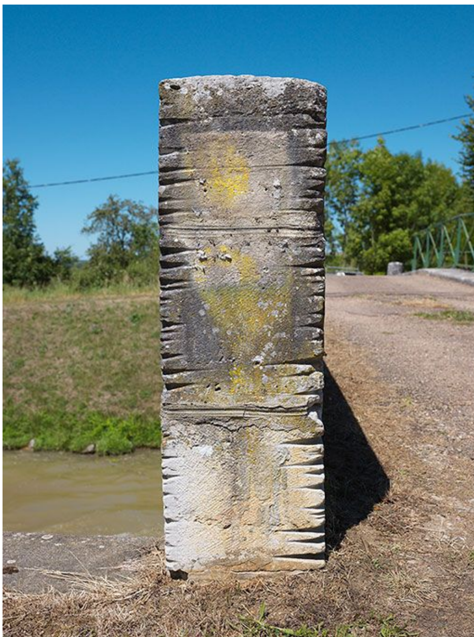
Détail des marques de halage.
