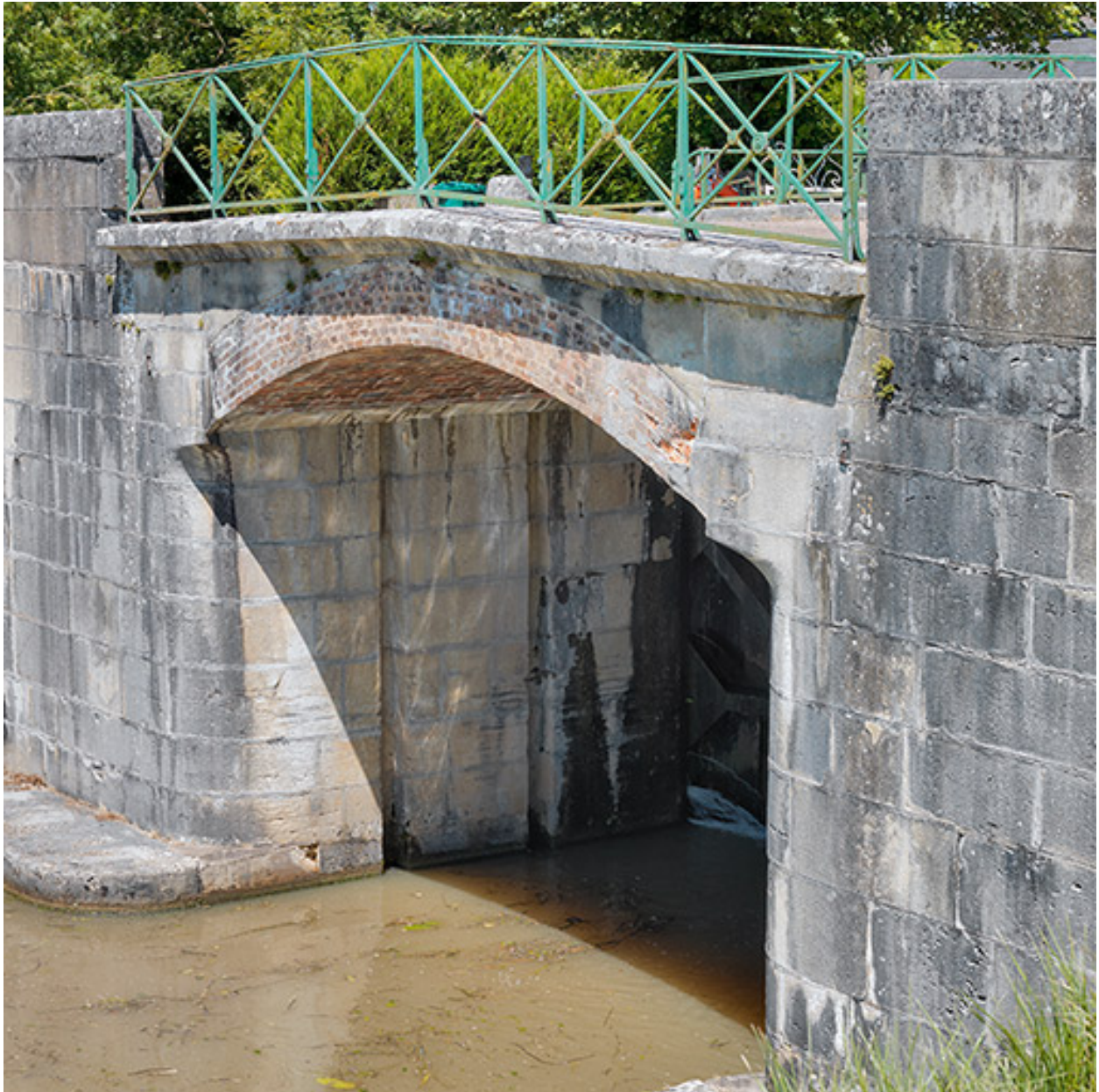
Vue rapprochée de la voûte en brique.
