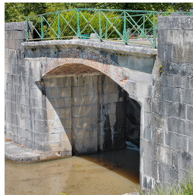
Vue rapprochée de la voûte en brique. Phot. Thierry Kuntz IVR26_20135800196NUC4A
