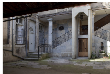
Vue du départ de l'escalier en fond de cour, de trois quarts droit. Phot. Yves Sancey IVR43_20102501010NUC2A
