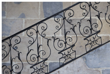
Escalier, première volée : détail de la rampe en ferronnerie. Phot. Yves Sancey IVR43_20102501014NUC2A
