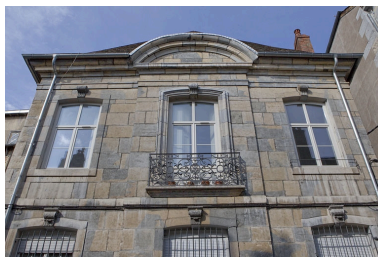
Aile droite : partie supérieure de la façade sur rue surmontée d'un fronton cintré. Phot. Yves Sancey IVR43_20102501016NUC2A
