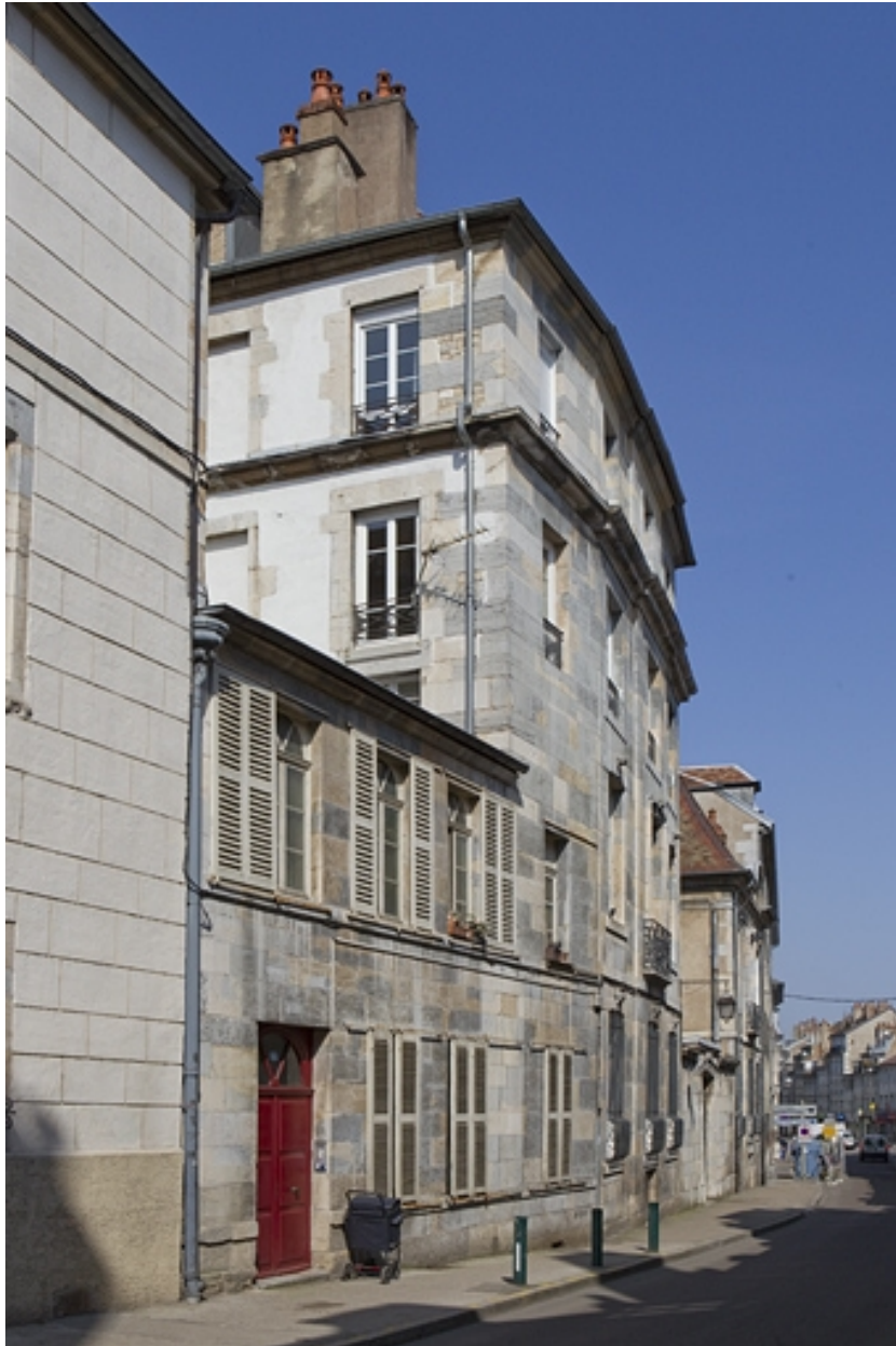
Vue d'ensemble depuis la rue, de trois quarts gauche.
