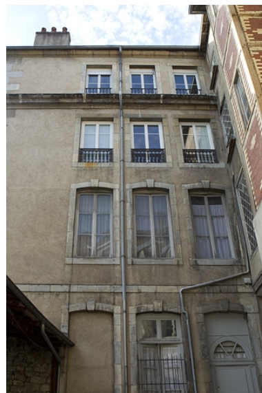
Vue d'ensemble de l'aile gauche sur cour. Phot. Yves Sancey IVR43_20102501006NUC2A
