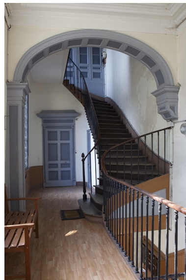
Vue des volées supérieures de l'escalier, de face. Phot. Yves Sancey IVR43_20102501013NUC2A
