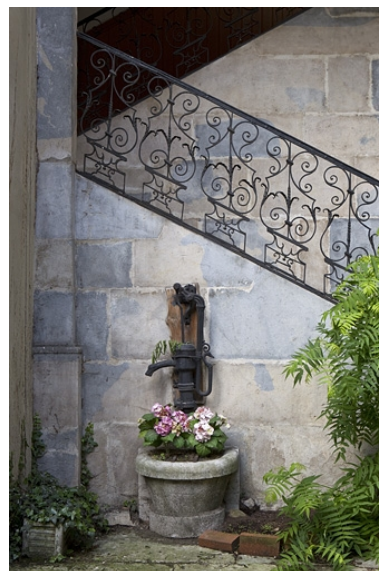
Escalier, première volée : détail de la rampe en ferronnerie et de la borne fontaine. Phot. Yves Sancey IVR43_20102501015NUC2A
