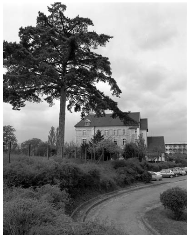
Vue d'ensemble éloignée. Phot. Yves Sancey IVR43_19917000241X
