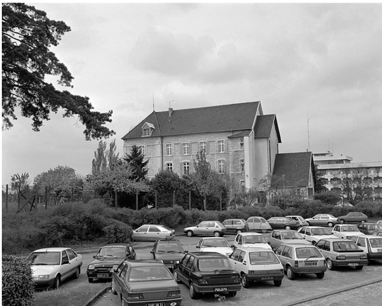
Vue d'ensemble rapprochée.
