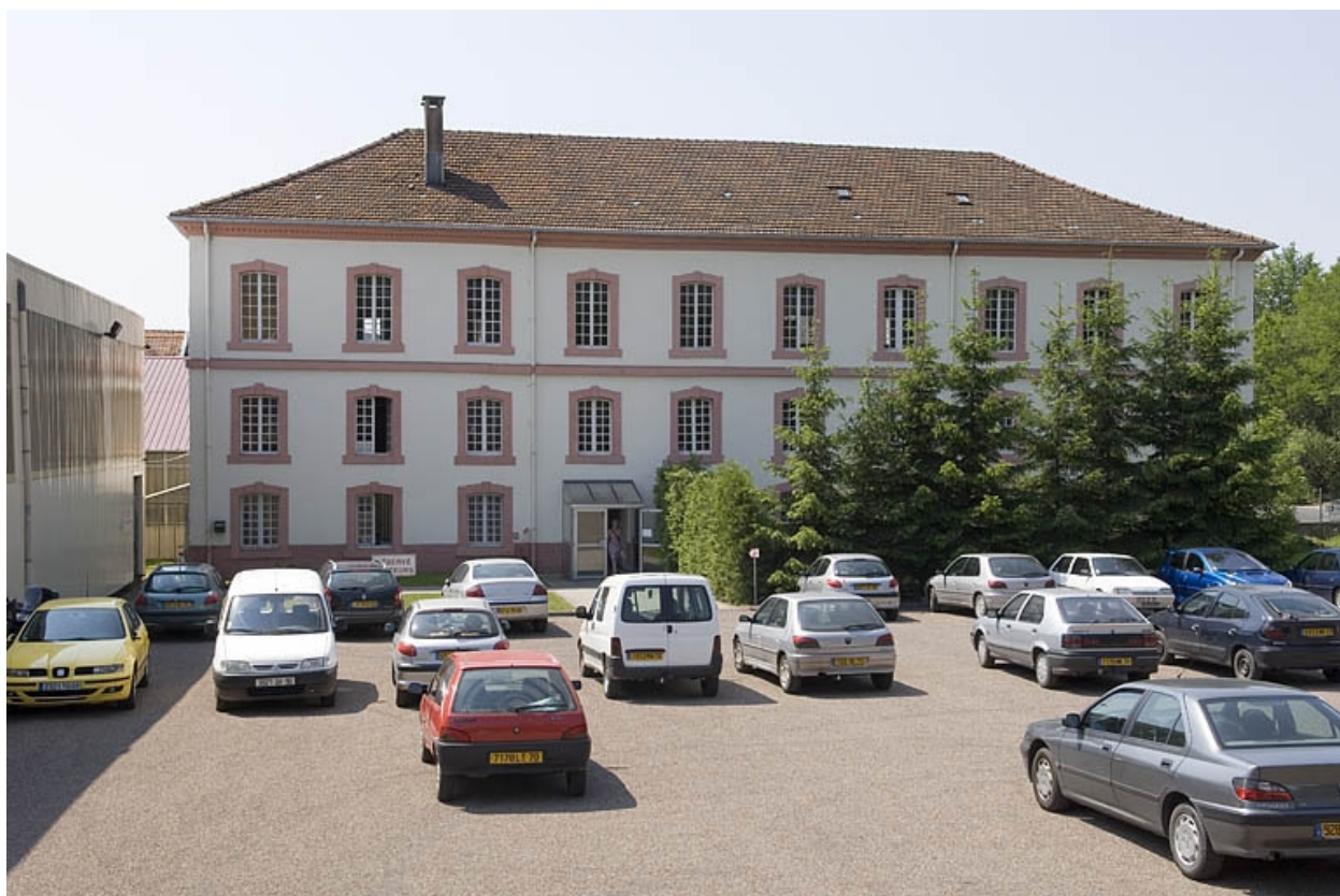
Immeuble de bureaux.
