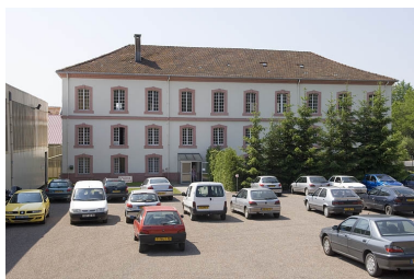
Immeuble de bureaux. Phot. Jérôme Mongreville IVR43_20067000523NUCA
