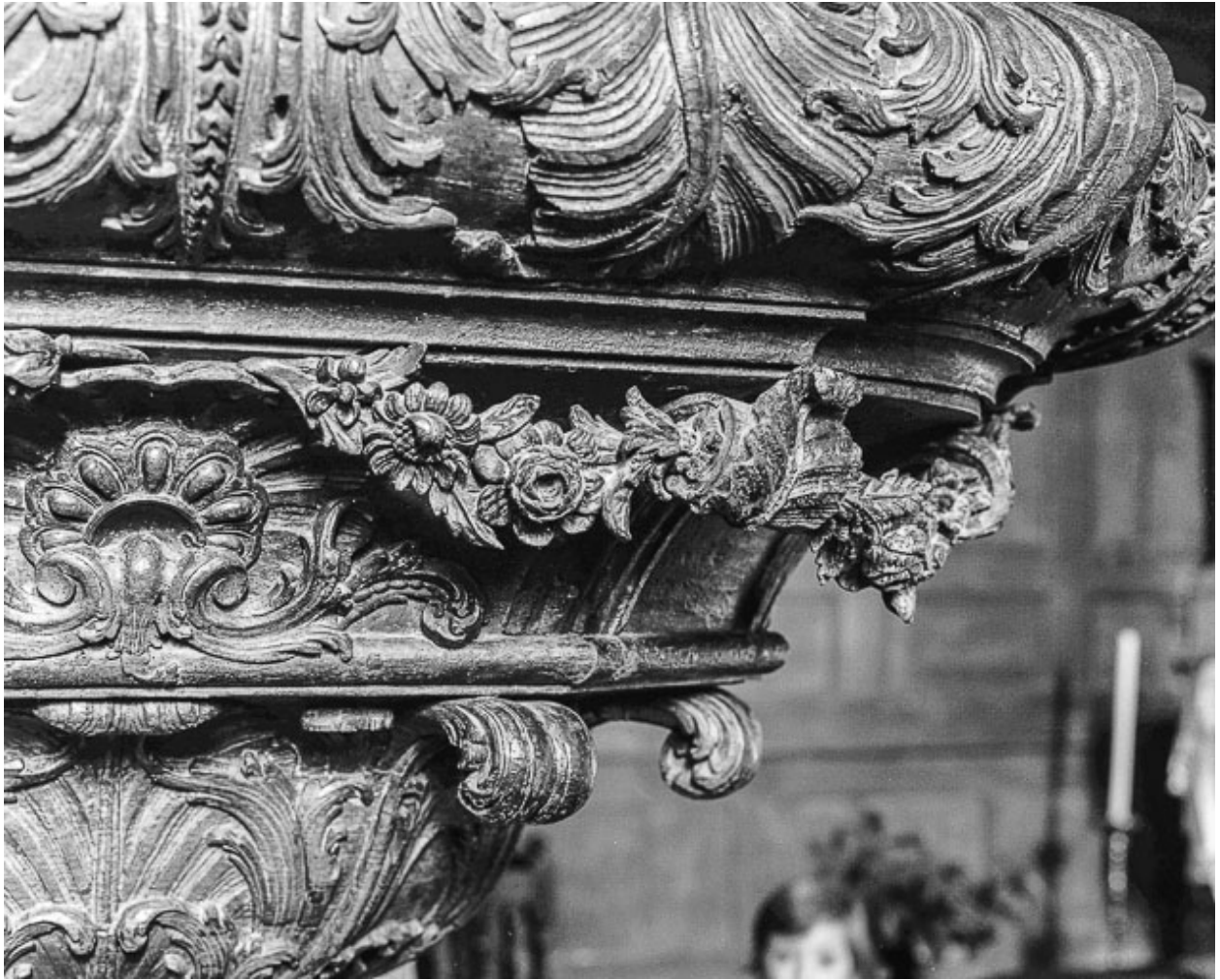
Cuve : détail du culot.
