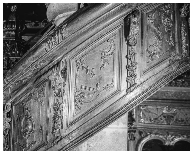
Un panneau de la rampe. Phot. Yves Sancey IVR43_19752501086X
