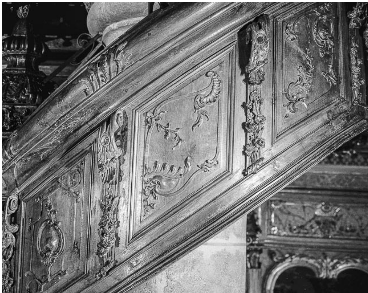
Un panneau de la rampe.
