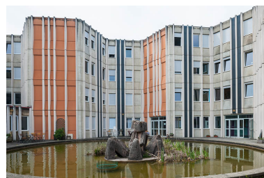
Vue rapprochée. Phot. Jérôme Mongreville IVR43_20142500361NUC4A
