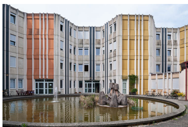
Vue du sol, l'oeuvre dans son contexte. Phot. Jérôme Mongreville IVR43_20142500360NUC4A
