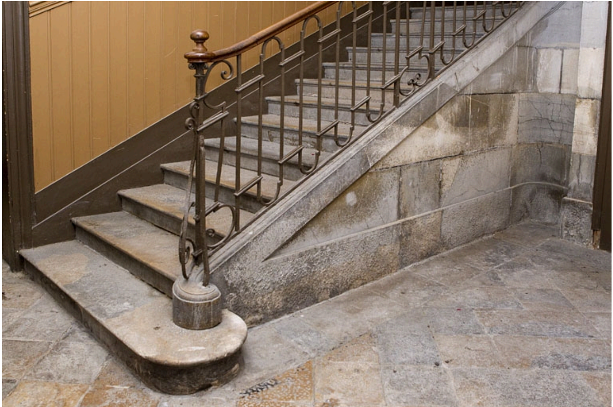
Détail du départ de l'escalier.
