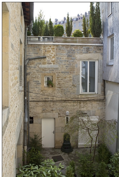
Vue de la façade antérieure de la maison donnant sur l'ancienne basse-cour. Phot. Yves Sancey IVR43_20102500443NUC2A
