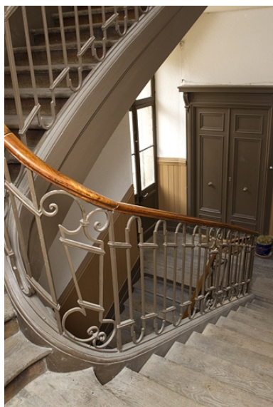
Vue de l'intérieur de l'escalier. Phot. Yves Sancey IVR43_20102500440NUC2A
