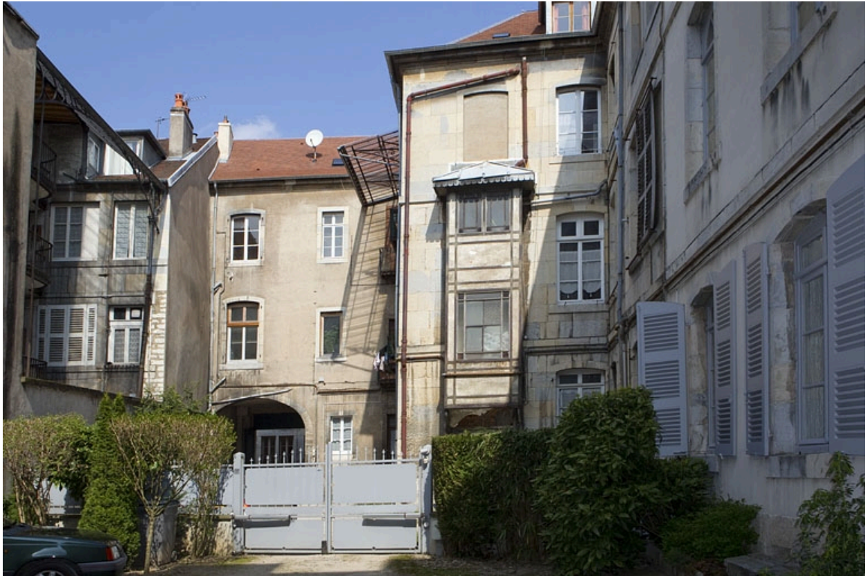
Vue de la façade postérieure du logis principal depuis le fond de la cour.
