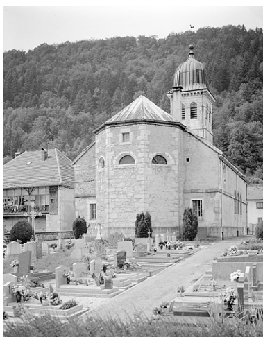
Le chevet, vu depuis le cimetière. Phot. Yves Sancey IVR43_19963900714V
