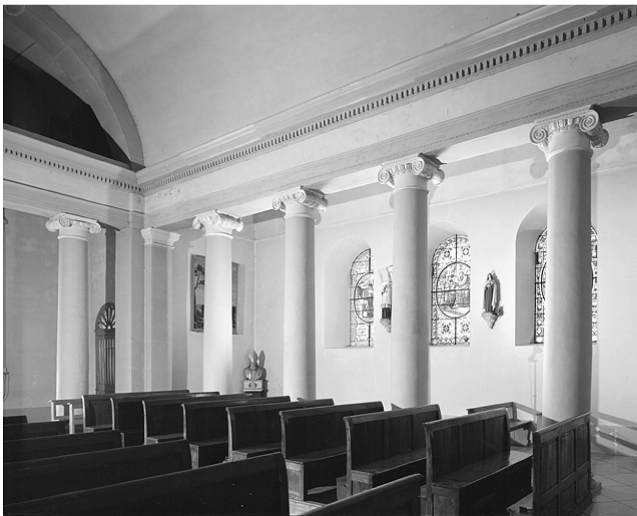
Elévation intérieure nord de la nef.
