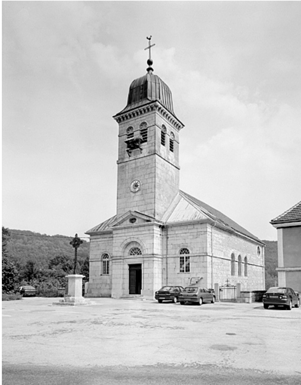
Façade antérieure et face droite.
