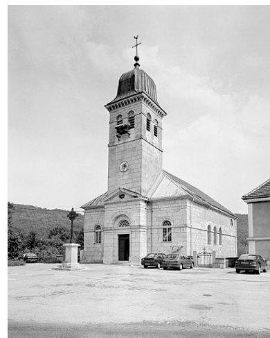
Façade antérieure et face droite.
