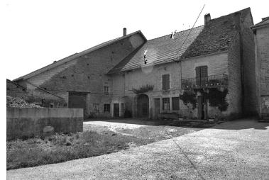
Fermes cadastrées 1965 AB 51-52, situées le long du chemin départemental n° 210 de Crançot à La Marre : façades antérieures. Phot. F. Pernin IVR43_19743900185Z
