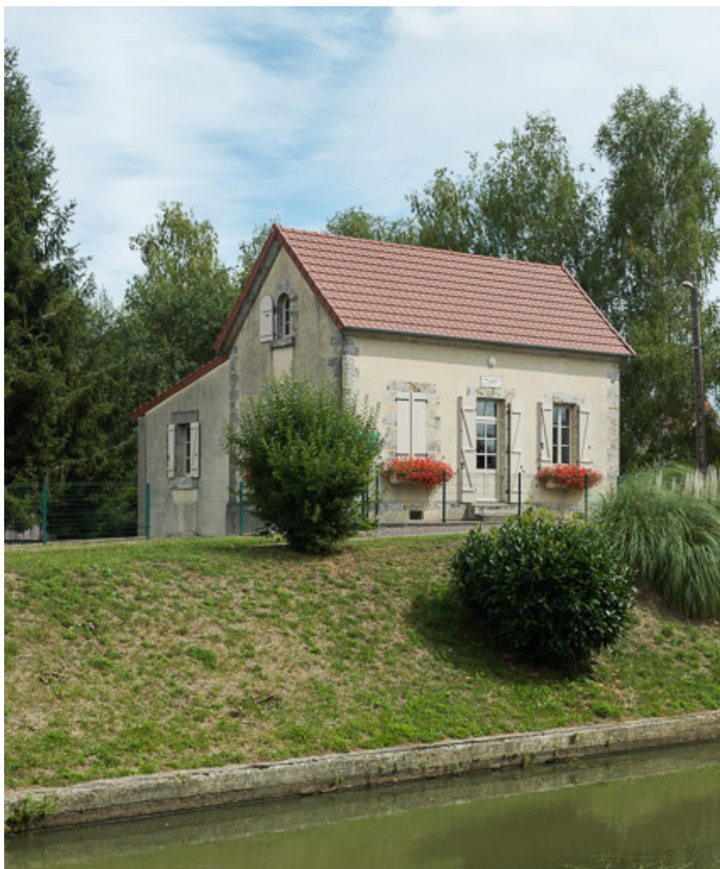
Vue rapprochée de la maison éclusière.
