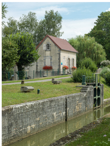
Vue de la maison éclusière.
