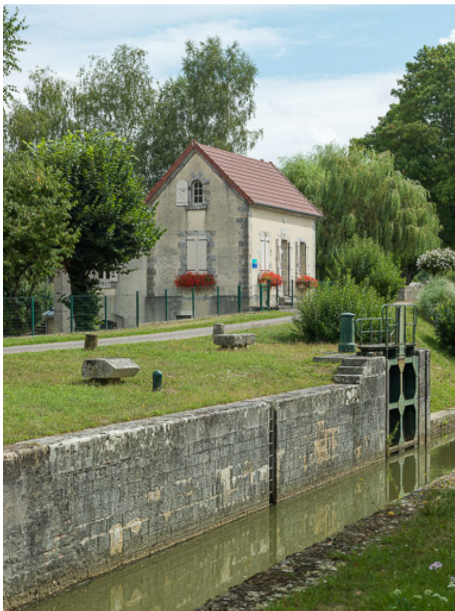
Vue de la maison éclusière.
