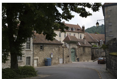
Vue d'ensemble du portail d'entrée depuis l'extérieur. Phot. Yves Sancey IVR43_20072500488NUCA
