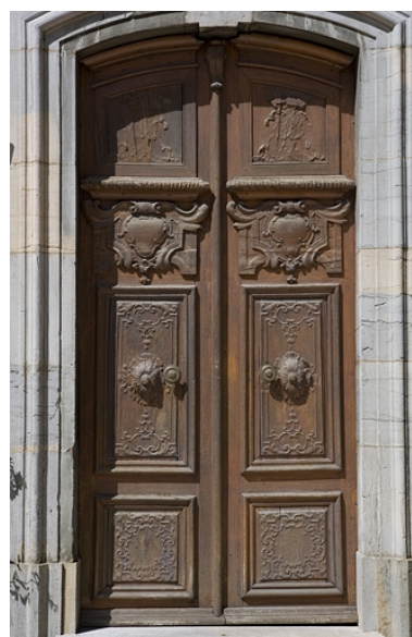
Détail des vantaux de la porte d'entrée du logis.
