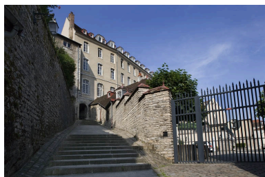
Vue de la façade postérieure depuis la rue du Chambrier. Phot. Yves Sancey IVR43_20072500484NUCA
