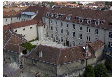
Vue d'ensemble rapprochée des bâtiments autour de la cour. Phot. Yves Sancey IVR43_20072500486NUCA
