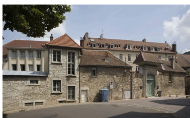
Vue d'ensemble rapprochée de la clôture et du portail depuis la rue. Phot. Yves Sancey IVR43_20072500489NUCA
