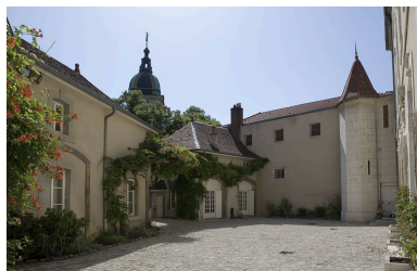
Détail des communs, de trois quarts gauche.
