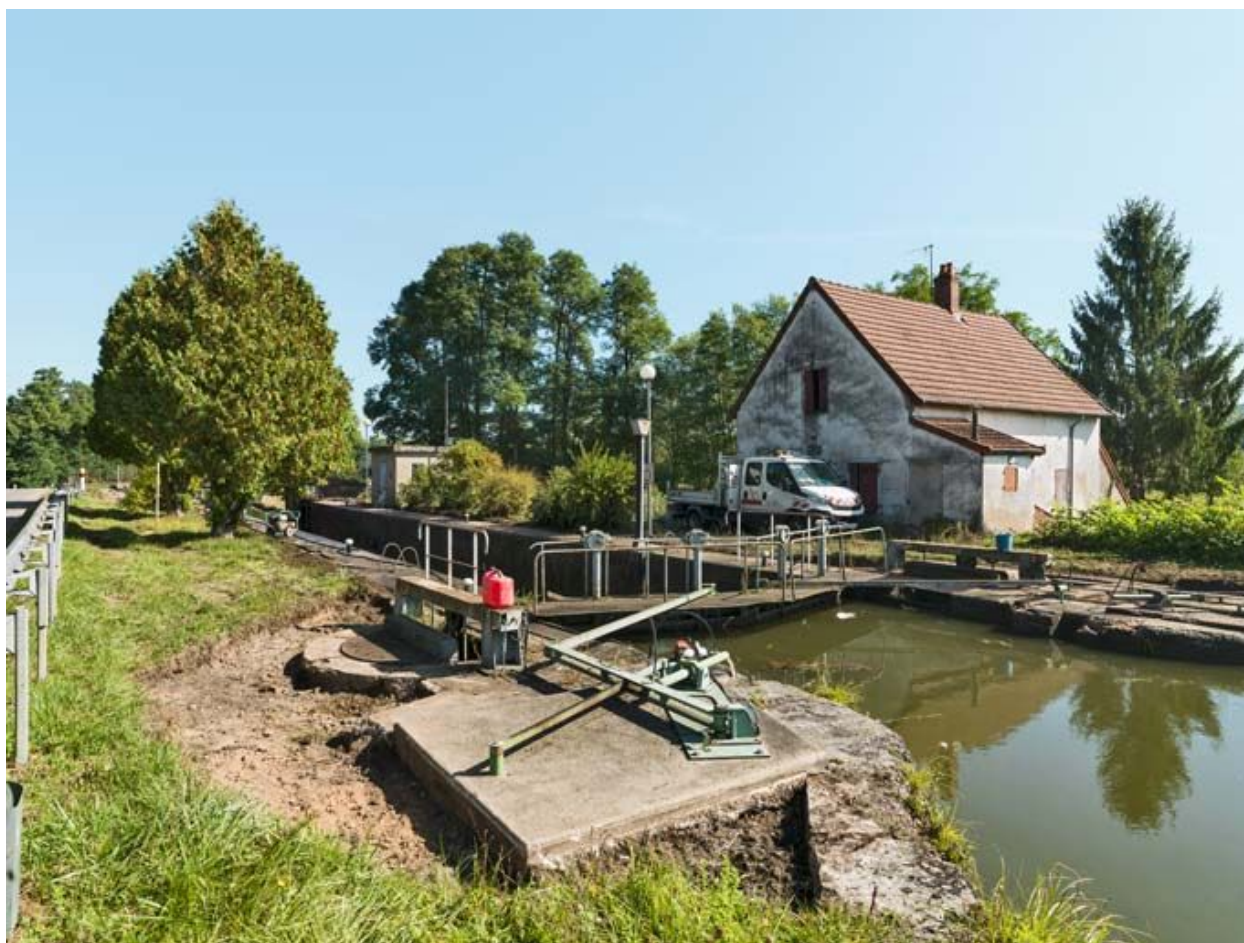
Vue d'ensemble du site d'écluse.
