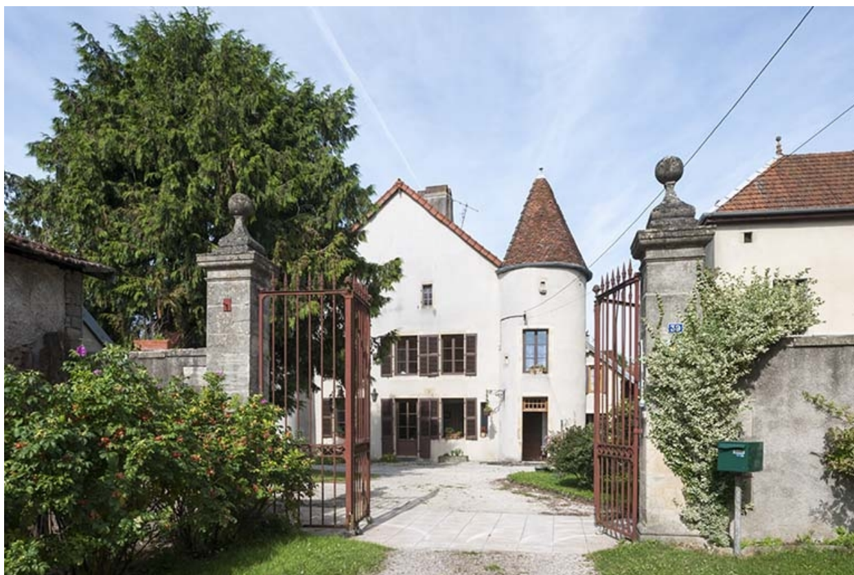
Vue rapprochée depuis la Grande Rue.
