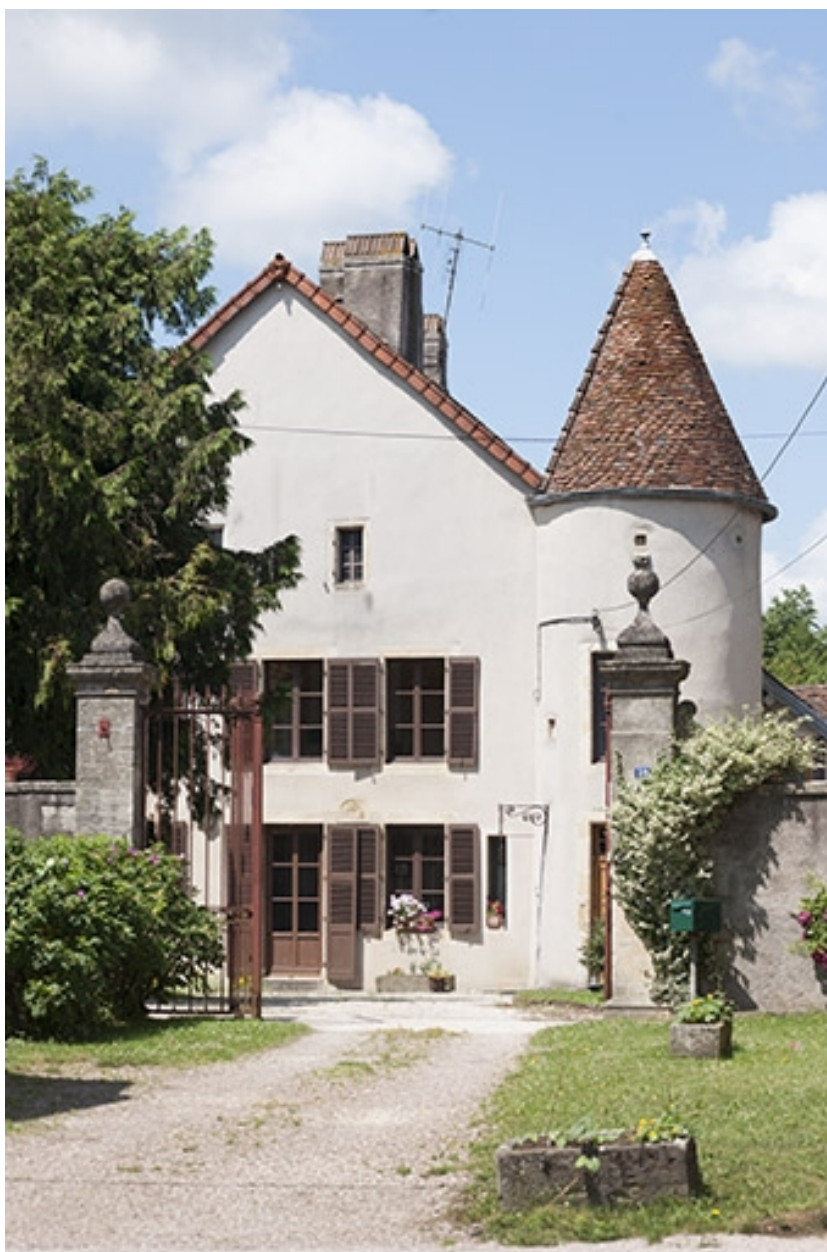
Façade antérieure et tour nord, depuis l'entrée.
