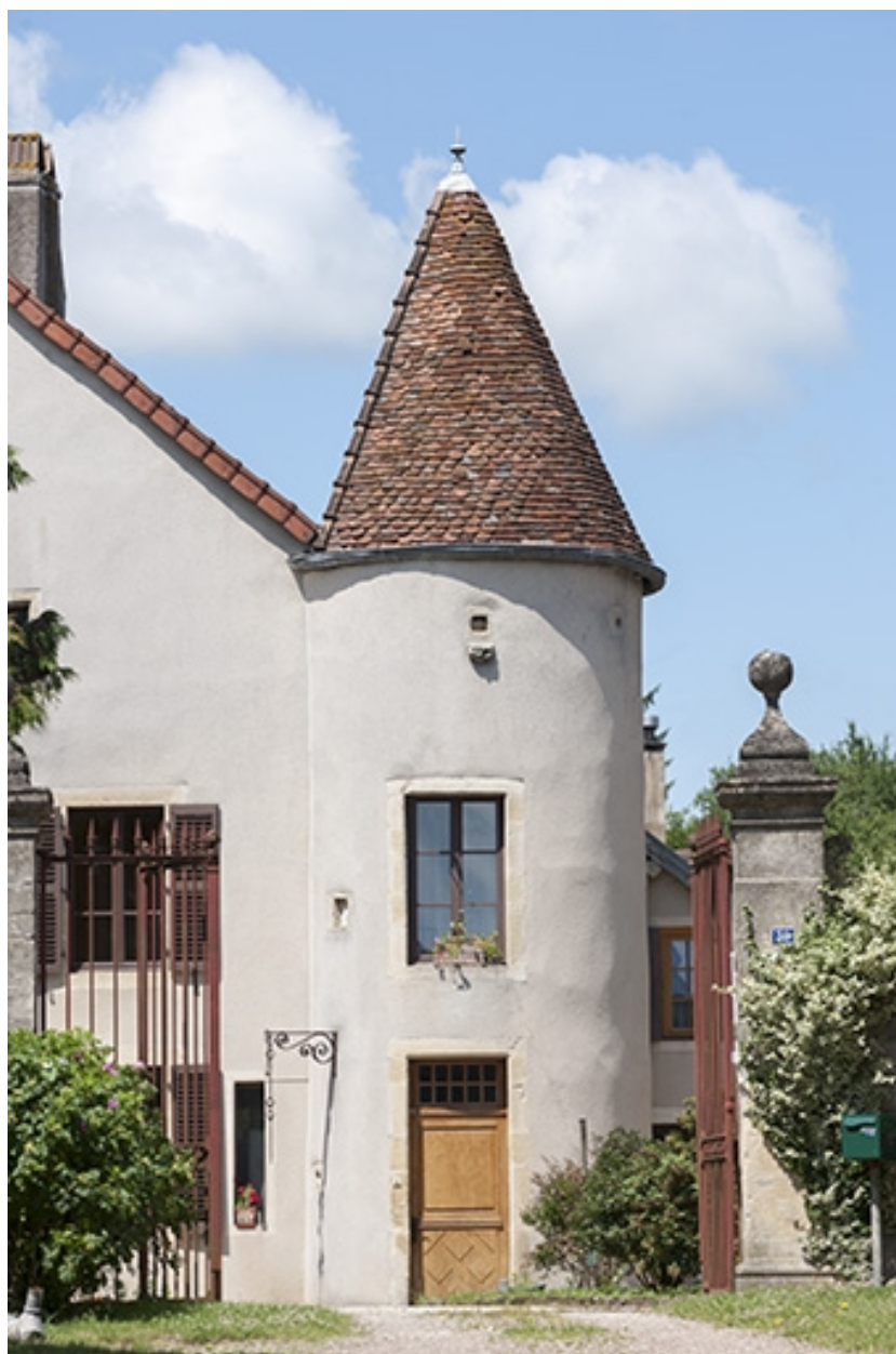
Façade antérieure et tour nord.
