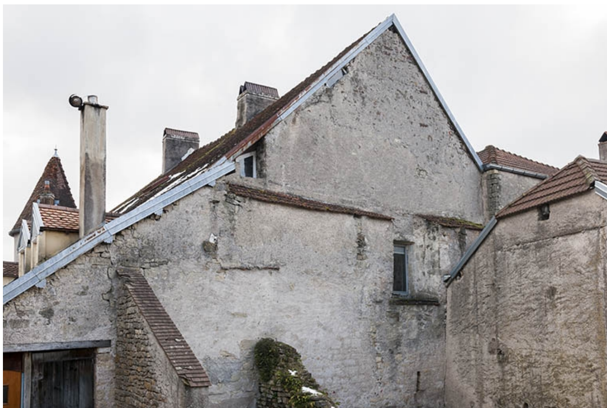
Façade postérieure côté rue Catinat.
