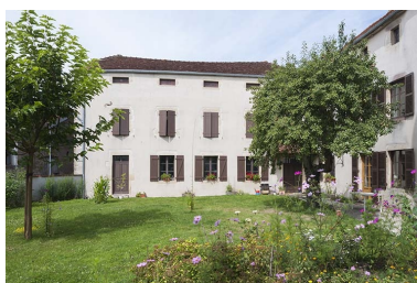
L'aile en retour d'équerre depuis le jardin. Phot. Jérôme Mongreville IVR43_20127000667NUC4A
