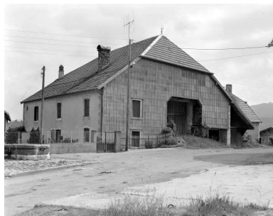
Façades antérieure et latérale droite.
