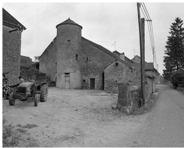
Façade sur la cour. Phot. Yves Sancey IVR43_19813900185X
