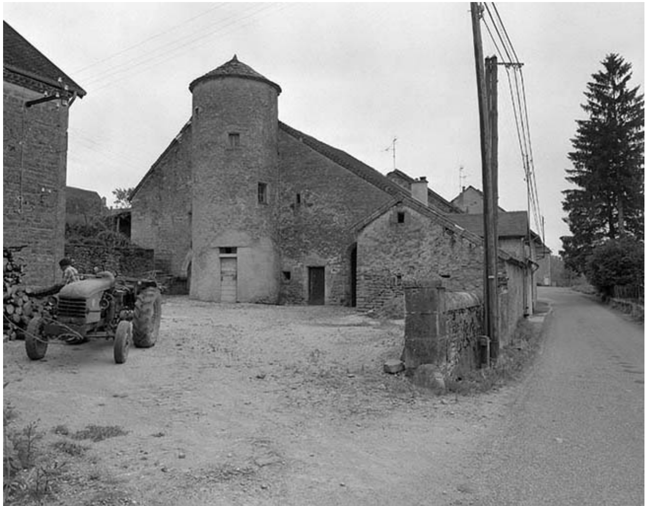
Façade sur la cour.
