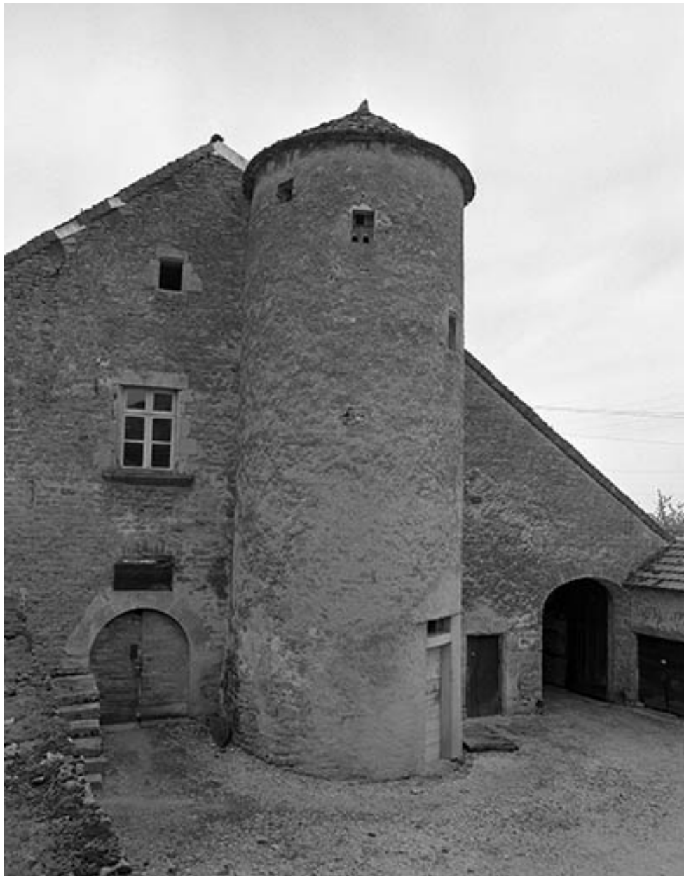
Façade sur la cour : la tourelle.
