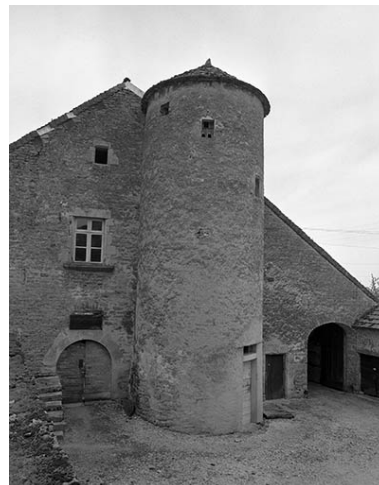
Façade sur la cour : la tourelle. Phot. Yves Sancey IVR43_19813900186X
