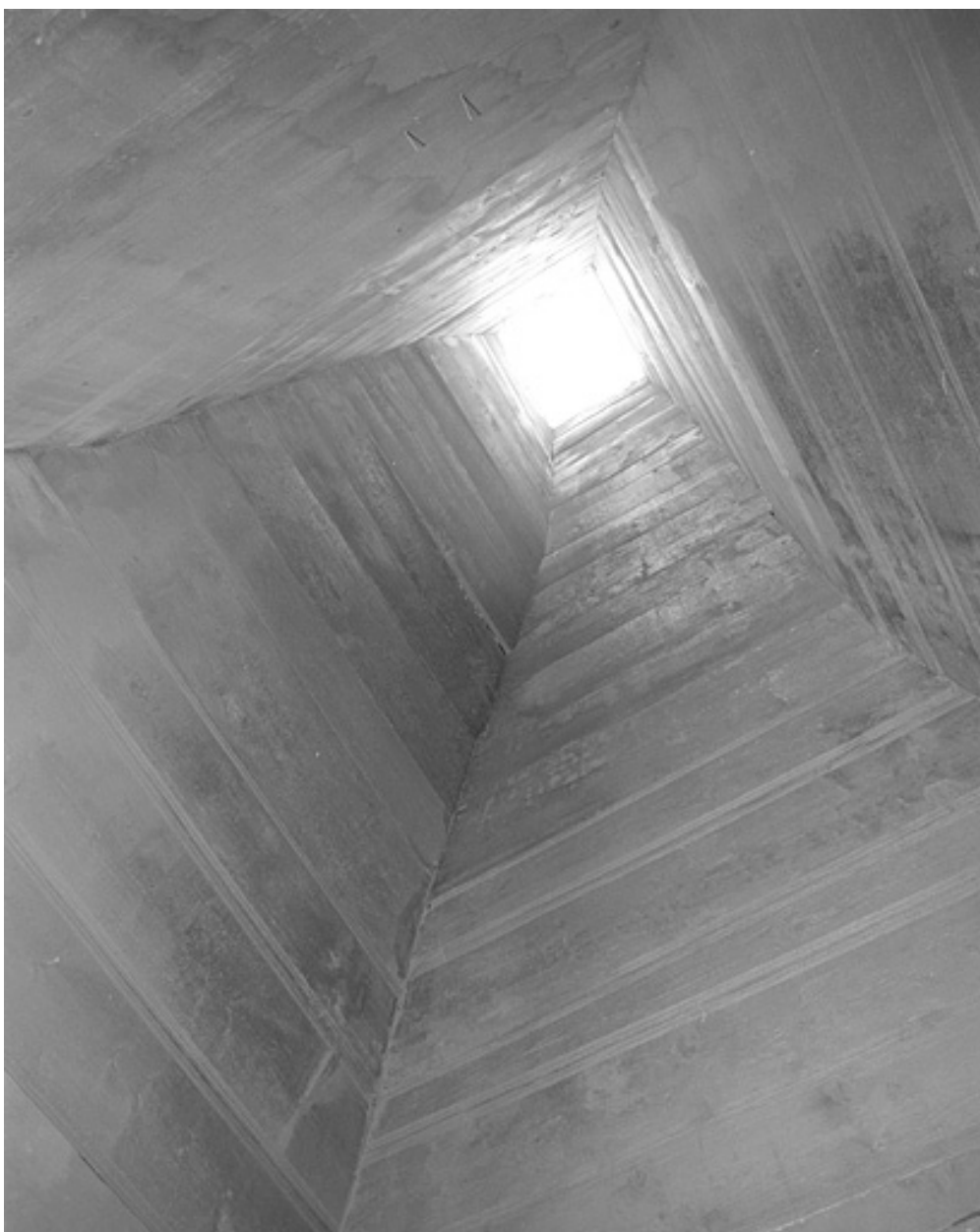
L'intérieur du conduit de la cheminée en bois.
