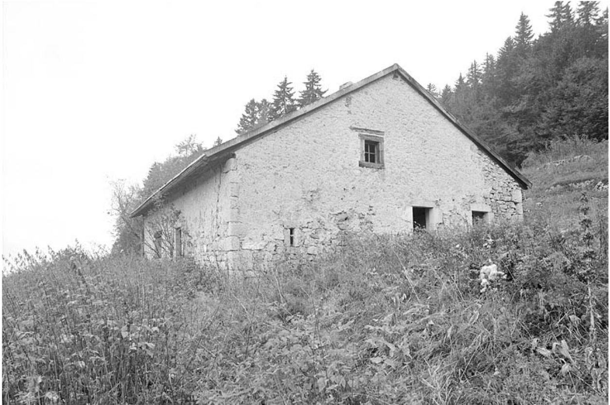
Face droite et façade antérieure.
