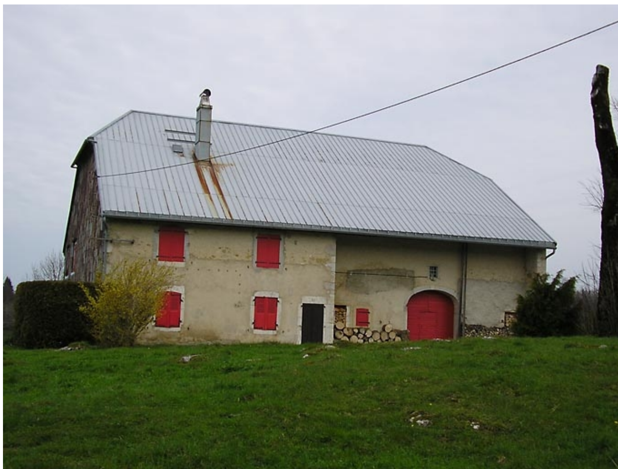
Vue générale de la façade postérieure.
