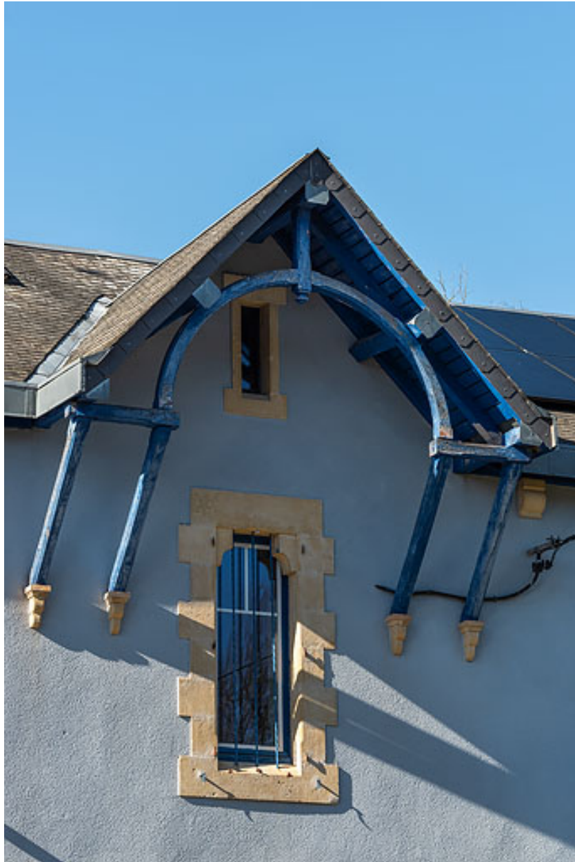
Lucarne-pignon à toiture débordante.
