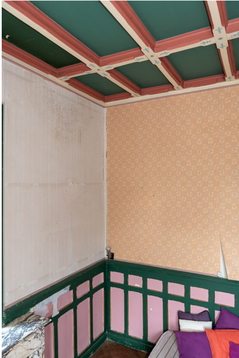
Salle à manger, décor du lambris d'appui et du plafond.
