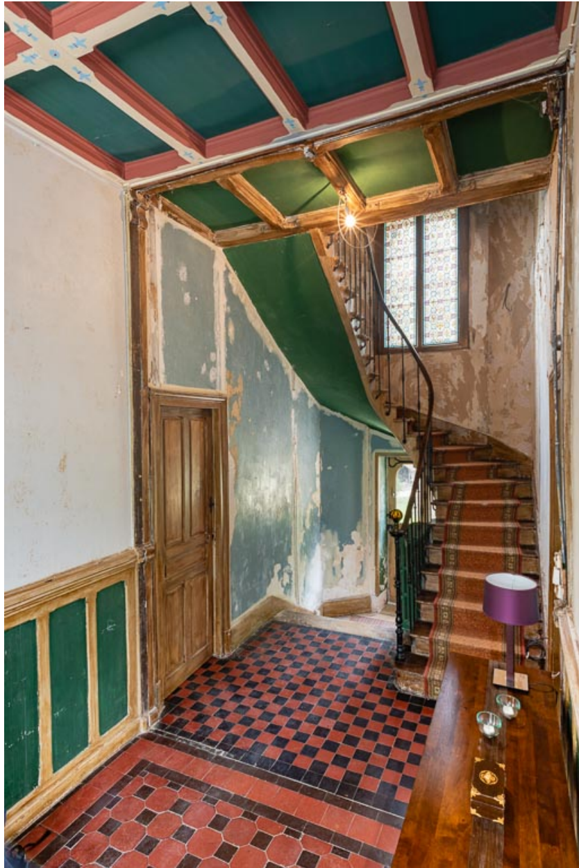
Vestibule et escalier, vue de trois-quarts.
