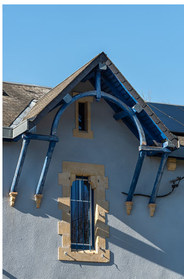
Lucarne-pignon à toiture débordante. Phot. Pierre-Marie Barbe-Richaud IVR26_20205800284NUC4A
