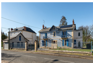
Façade sur l'avenue, vue de trois-quarts depuis l'est. Phot. Pierre-Marie Barbe-Richaud IVR26_20205800279NUC4A
