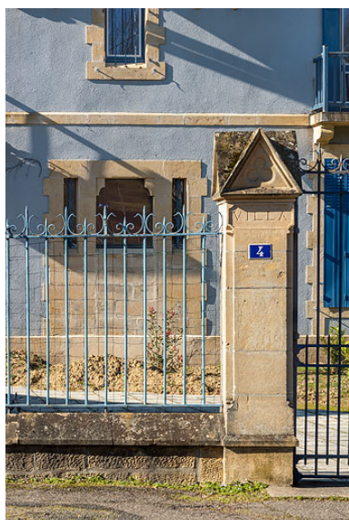
Grille et portail sur l'avenue, pilier gauche. Phot. Pierre-Marie Barbe-Richaud IVR26_20205800285NUC4A
