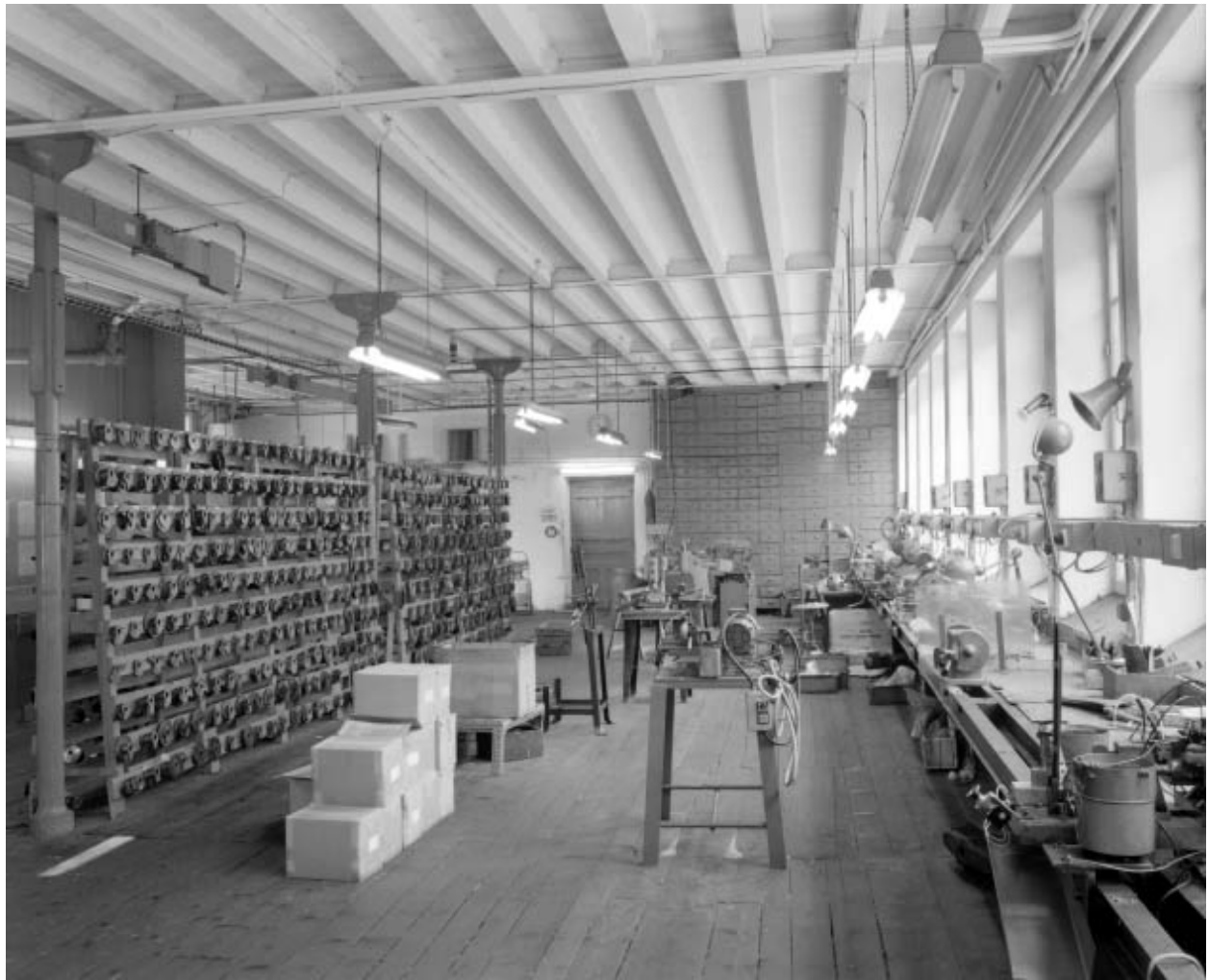
Entrepôt au 1er étage du bâtiment de 1902.
