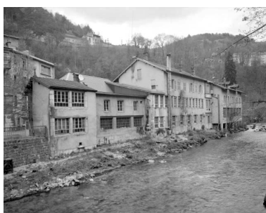
Façades sur le Tacon. Phot. Jérôme Mongreville IVR43_19923900377X
