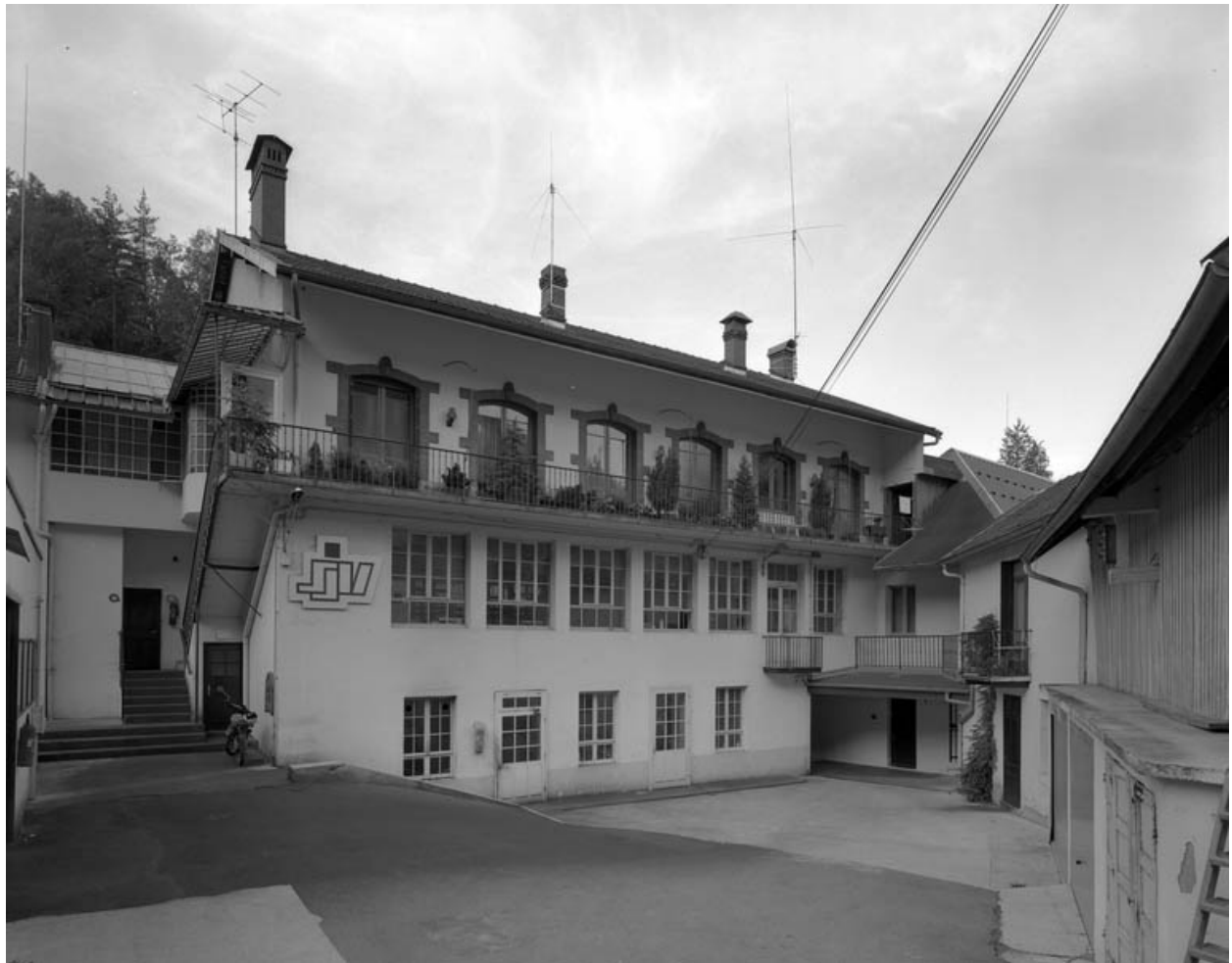
Façade sur cour du bâtiment de 1902.
