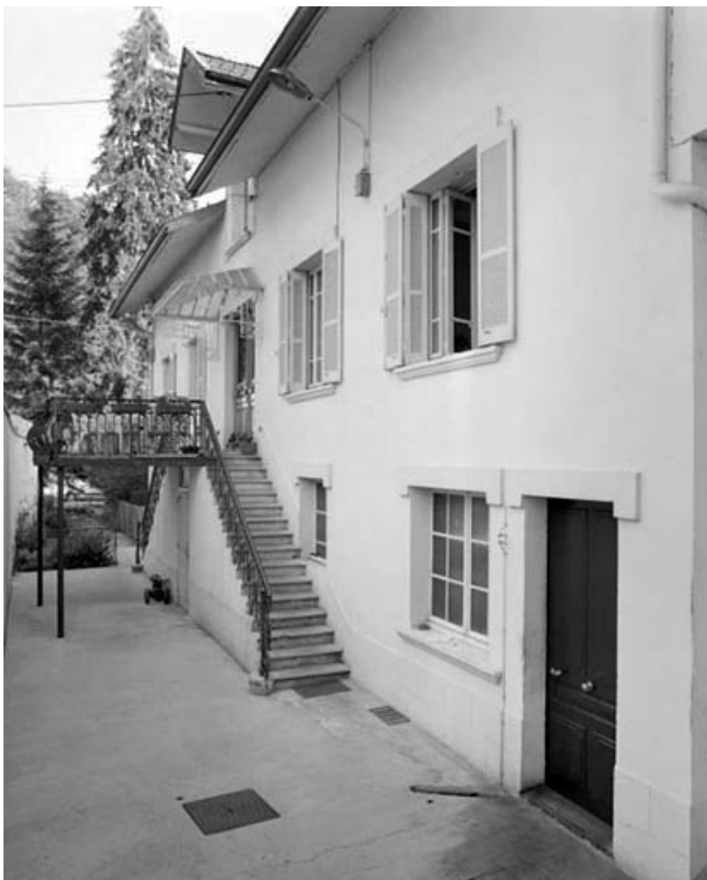
Façade sur cour du bâtiment de 1927.
