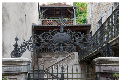
Porte sur cour. Partie supérieure de la ferronnerie. Phot. Nicolas Waltefaugle IVR43_20253900298NUC4A
