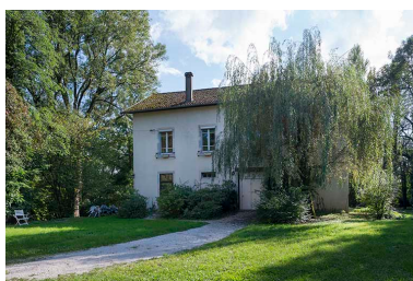
Logement ouvrier et remise. Phot. Jérôme Mongreville IVR43_20172501089NUC4A
