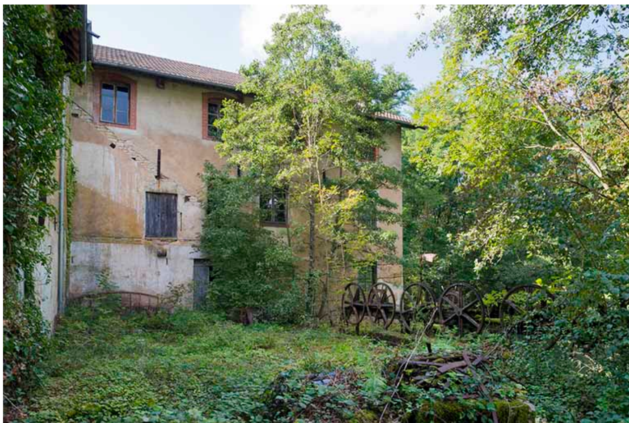
Façade postérieure de l'atelier de fabrication.
