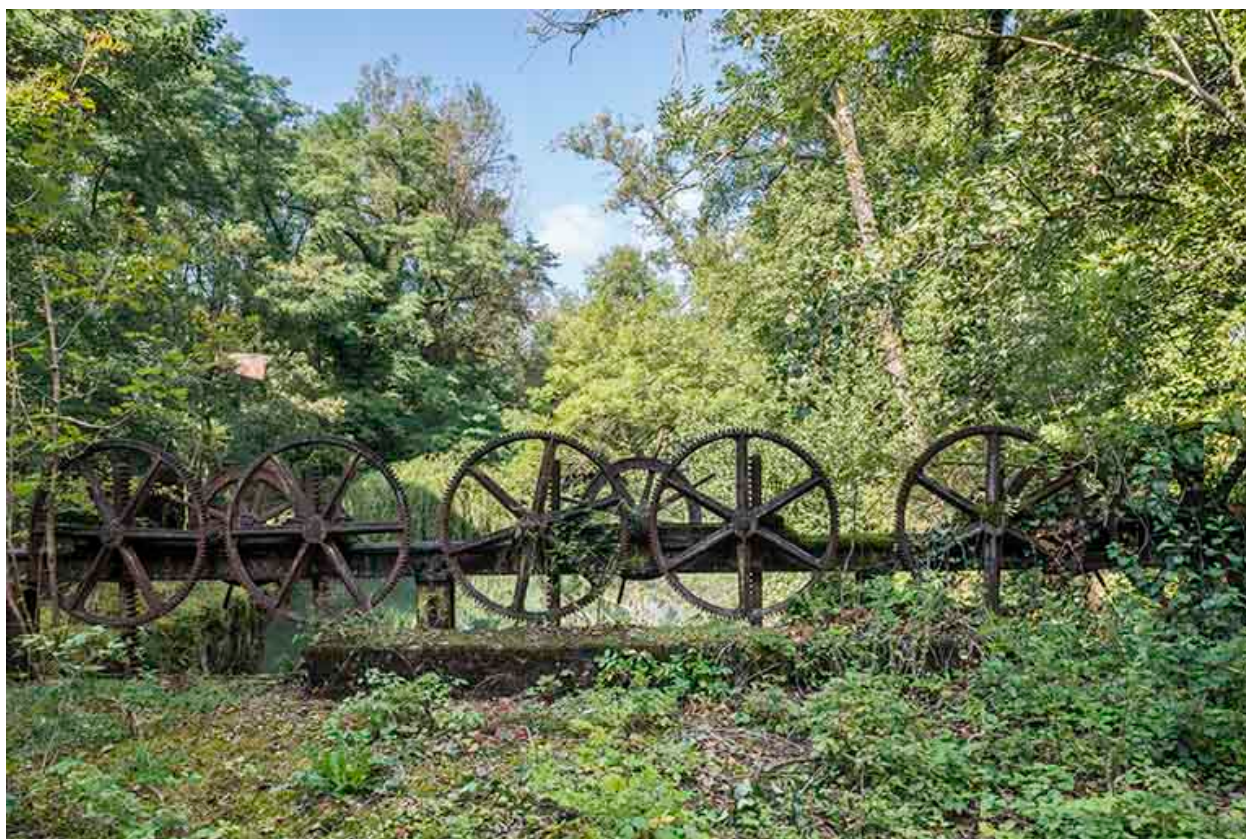
Mécanisme de levage du vannage (canal d'amenée).
