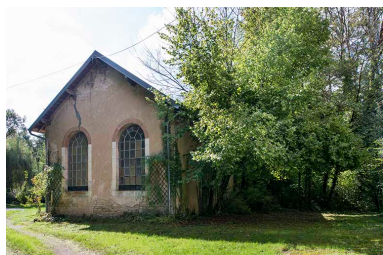
Local de la machine à vapeur (ou chaudière ?). Phot. Jérôme Mongreville IVR43_20172501074NUC4A
