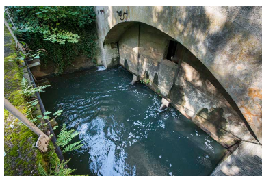
Canal de fuite en sortie de l'atelier. Phot. Jérôme Mongreville IVR43_20172501073NUC4A
