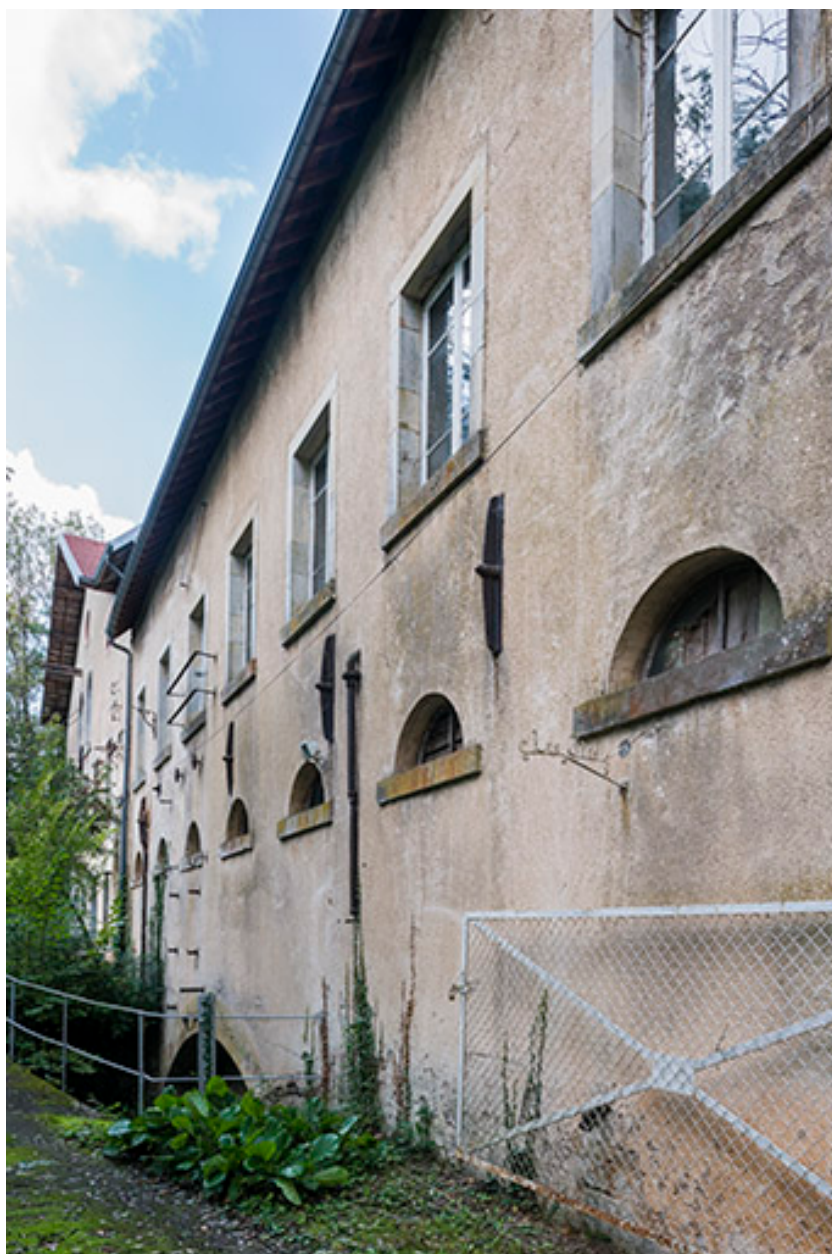
Façade antérieure. Vue depuis l'entrée.
