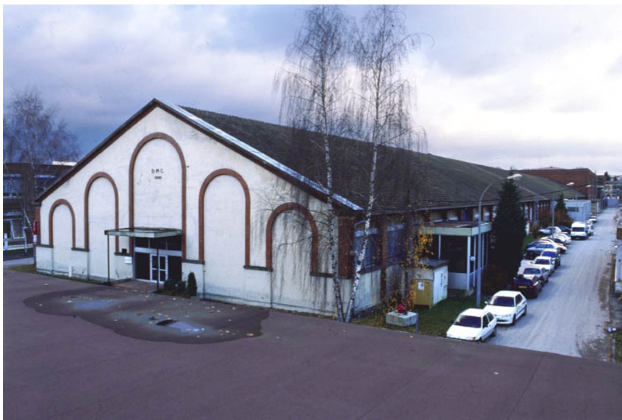
Atelier de retordage : vue depuis le nord-ouest.
