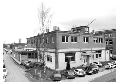
Atelier de blanchiment : vue de trois quarts gauche. Phot. Jérôme Mongreville IVR43_20019000676X
