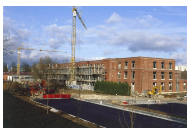
Atelier de filature : vue d'ensemble depuis le sud. Phot. Jérôme Mongreville IVR43_20019000713ZA
