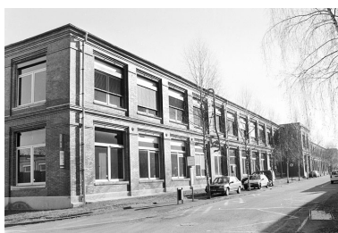
Atelier de finissage : façade ouest. Phot. Jérôme Mongreville IVR43_20019000685X
