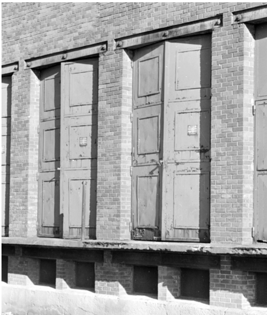
Transformateur : détail des portes métalliques.
