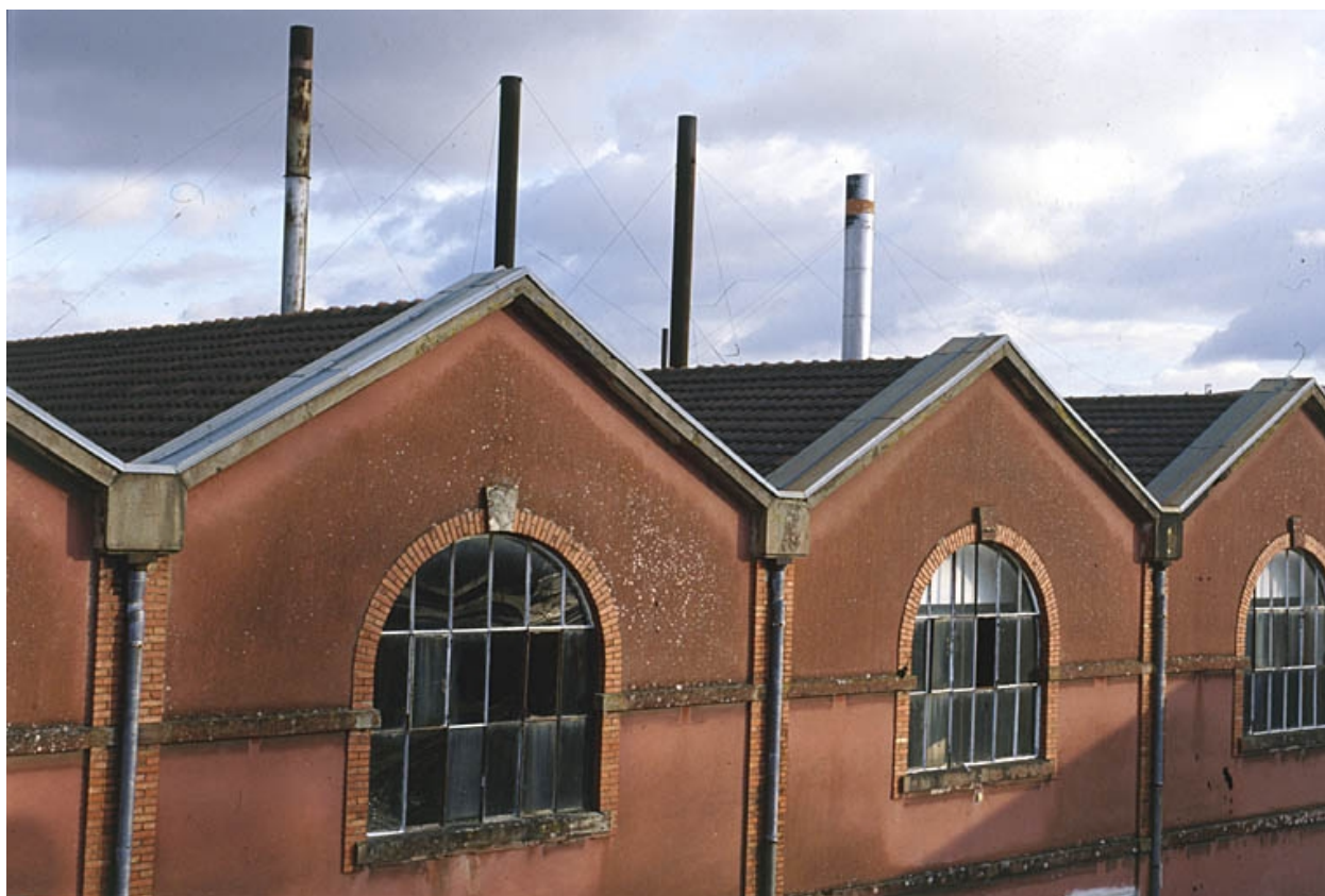
Chaufferie : façade ouest.
