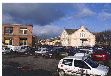
Atelier de finissage et bâtiment des magasins et des bureaux : vue de trois quarts. Phot. Jérôme Mongreville IVR43_20019000647ZA
