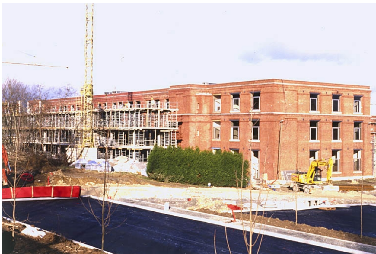
Atelier de filature : vue depuis le sud.
