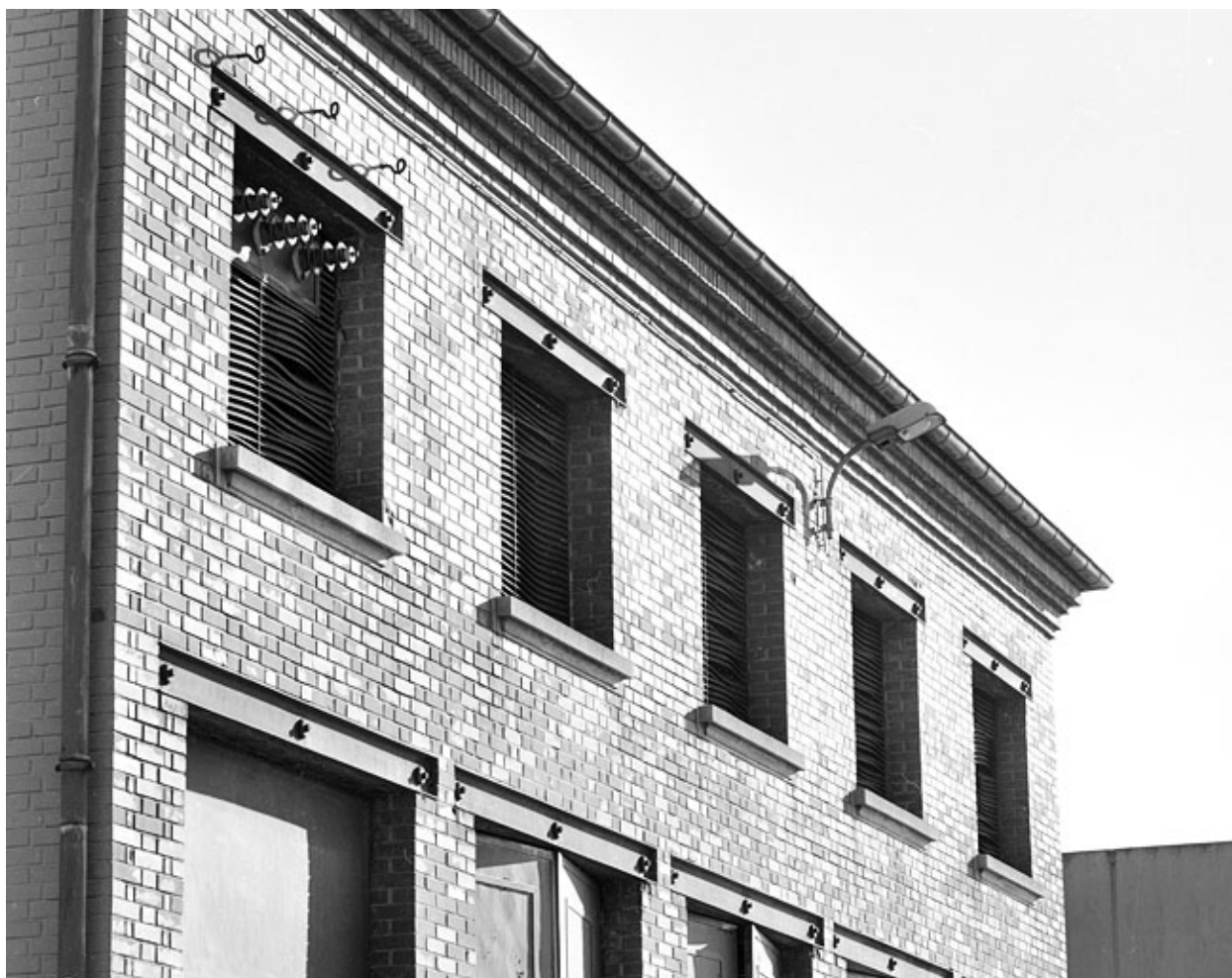
Transformateur : baies supérieures de la façade ouest.
