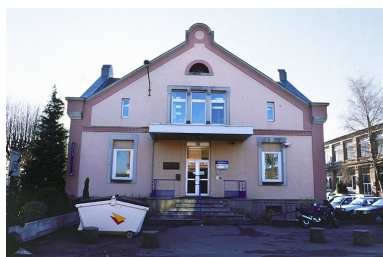
Bureaux situés à l'extrémité nord du bâtiment des magasins. Phot. Jérôme Mongreville IVR43_20019000644ZA
