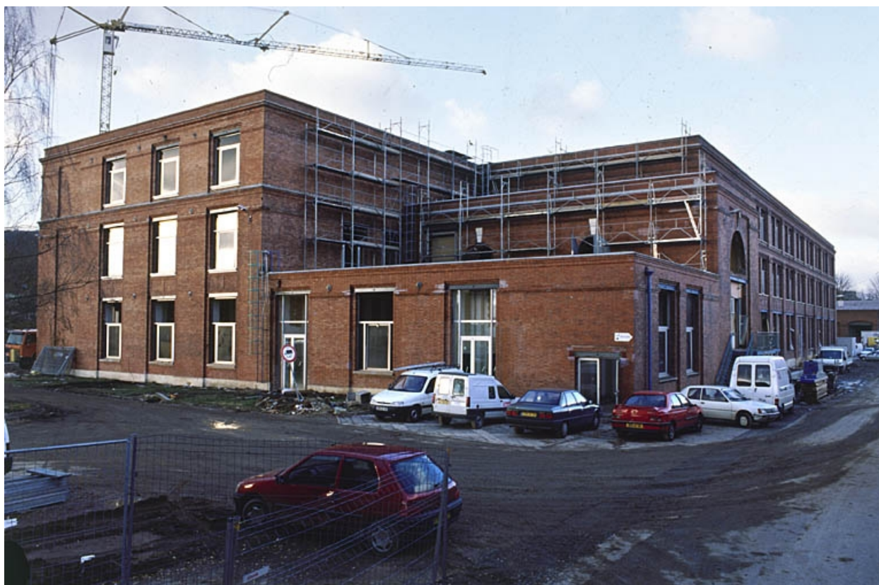
Atelier de filature : vue depuis le sud-est.
