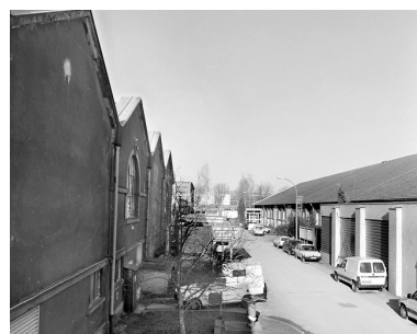
Allée située entre l'atelier de blanchiment et celui de retordage. Phot. Jérôme Mongreville IVR43_20019000693X
