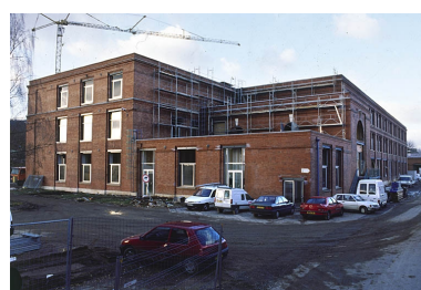
Atelier de filature : vue depuis le sud-est. Phot. Jérôme Mongreville IVR43_20019000662ZA
