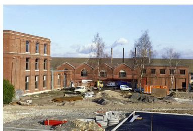
Atelier de filature, chaufferie et transformateur : vue depuis l'ouest. Phot. Jérôme Mongreville IVR43_20019000698ZA
