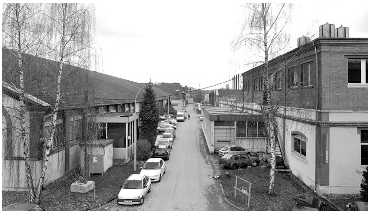
Allée située entre l'atelier de retordage et celui de blanchiment : vue depuis le nord.
