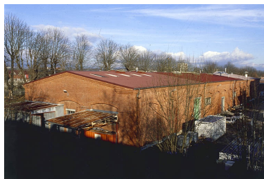
Magasin et entrepôt industriel. Phot. Jérôme Mongreville IVR43_20019000709ZA
