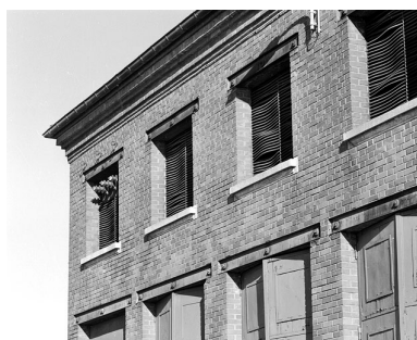
Transformateur : détail des baies supérieures de la façade ouest. Phot. Jérôme Mongreville IVR43_20019000681X
