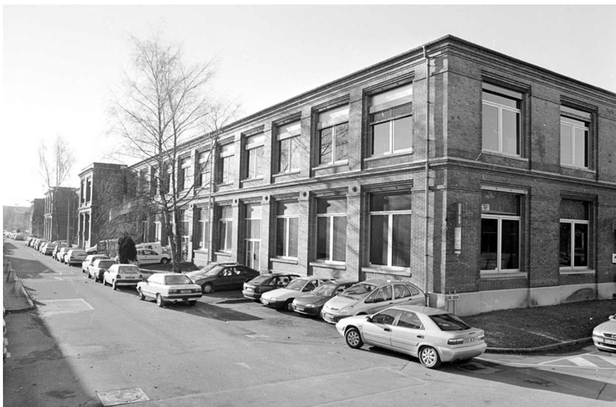
Atelier de finissage : façade est.
