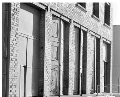
Transformateur : niveau des portes métalliques de la façade ouest. Phot. Jérôme Mongreville IVR43_20019000680X
