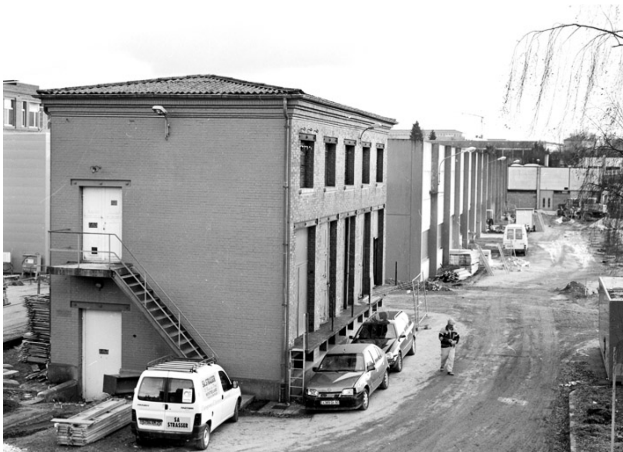
Transformateur : vue depuis l'atelier de filature.
