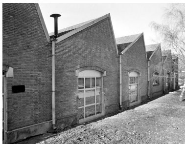
Atelier de teinturerie : détail des pignons de la façade est. Phot. Jérôme Mongreville IVR43_20019000703X
