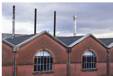
Chaufferie : détail des pignons ouest. Phot. Jérôme Mongreville IVR43_20019000700ZA
