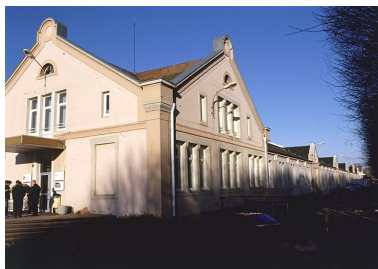
Bâtiment des bureaux et des magasins : façade est. Phot. Jérôme Mongreville IVR43_20019000640ZA
