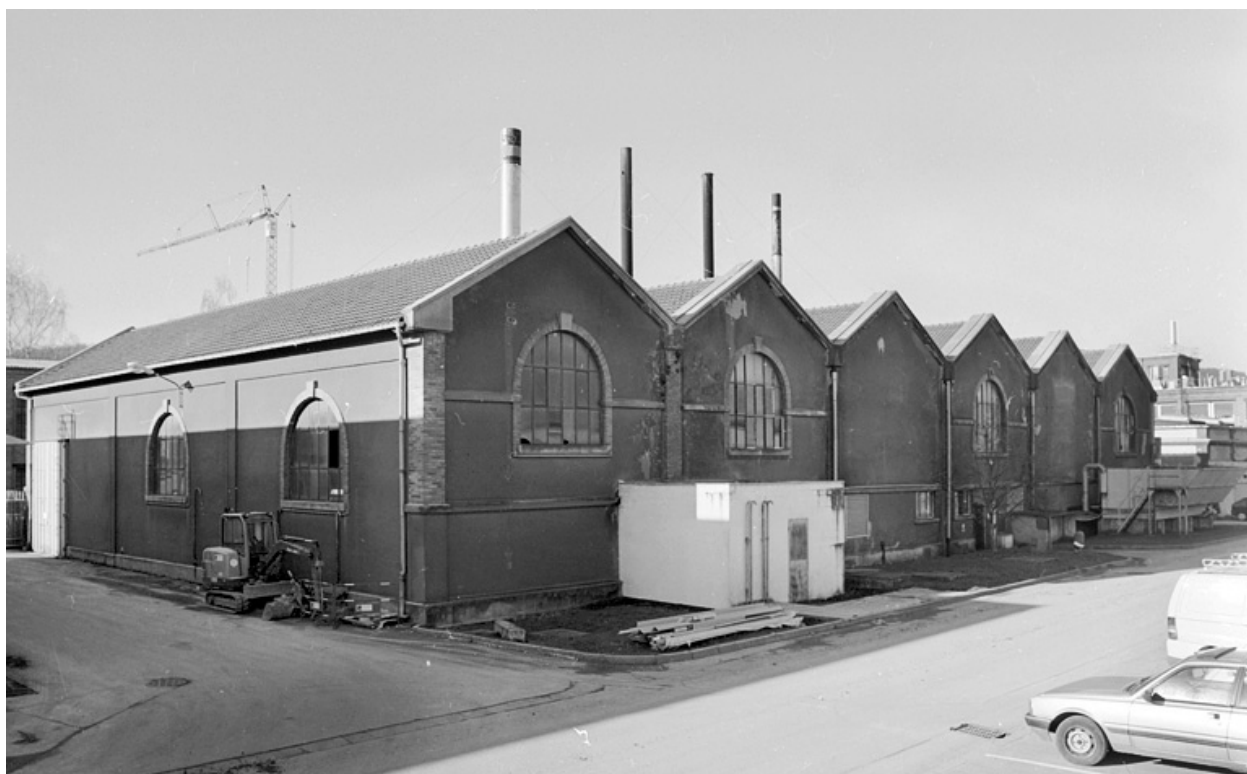
Chaufferie : vue depuis le sud-est.
