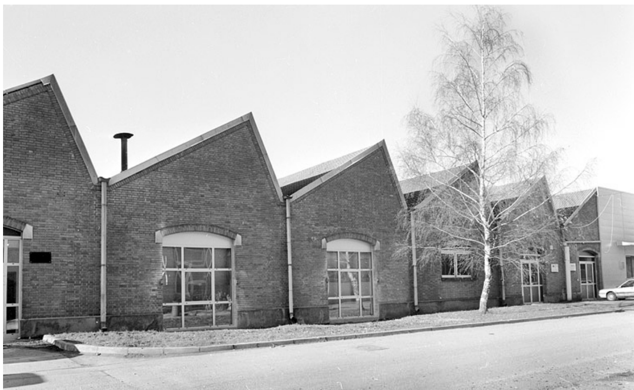
Atelier de teinturerie : façade est.
