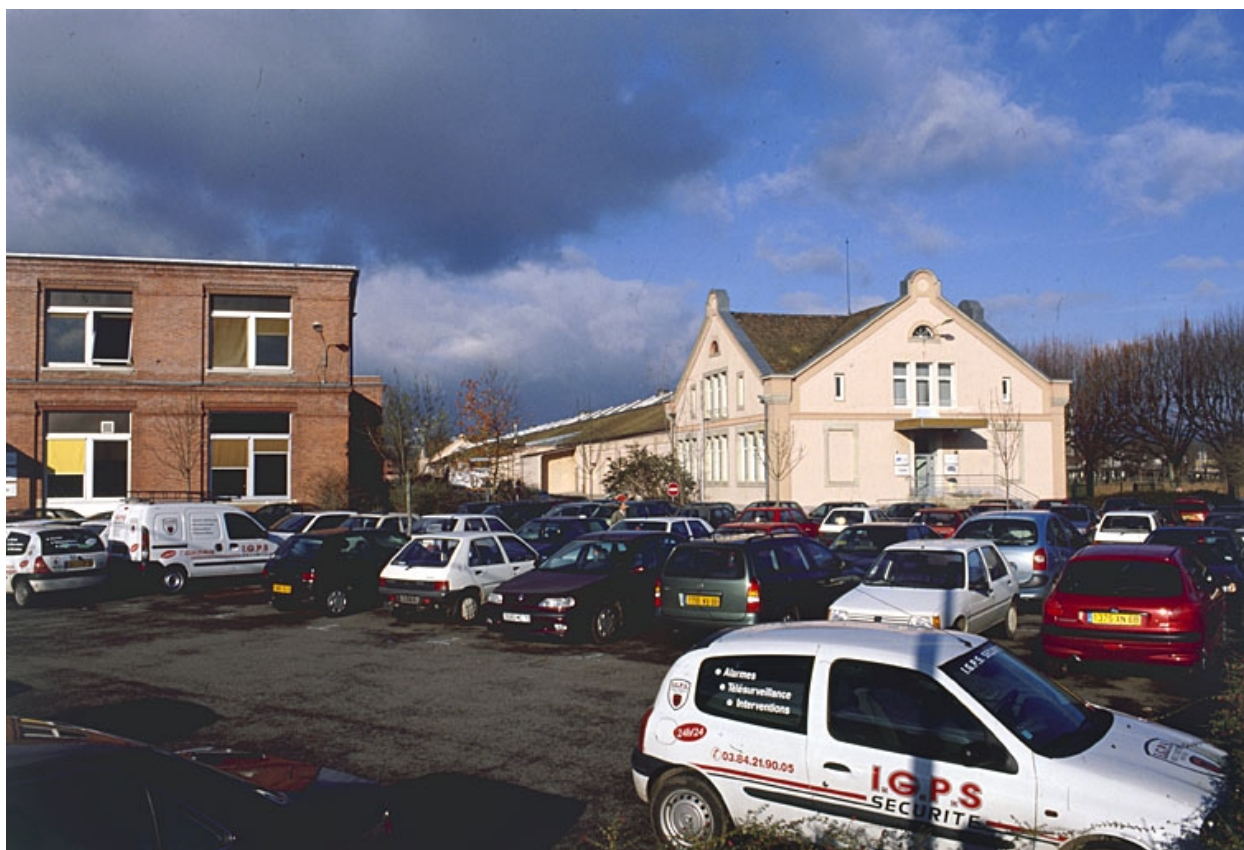
Atelier de finissage et bâtiment des magasins et des bureaux : vue de trois quarts.
