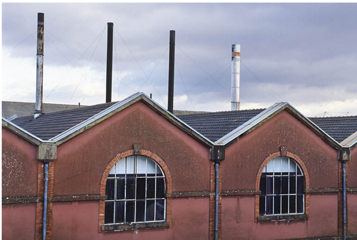
Chaufferie : détail des pignons ouest.
