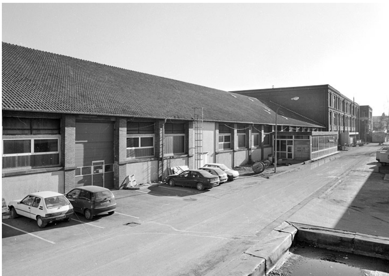
Atelier de retordage : façade ouest à mi-parcours.
