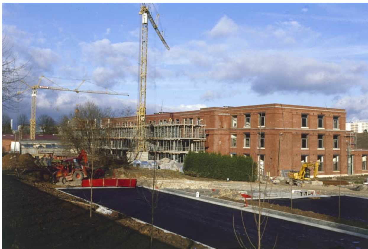
Atelier de filature : vue d'ensemble depuis le sud.
