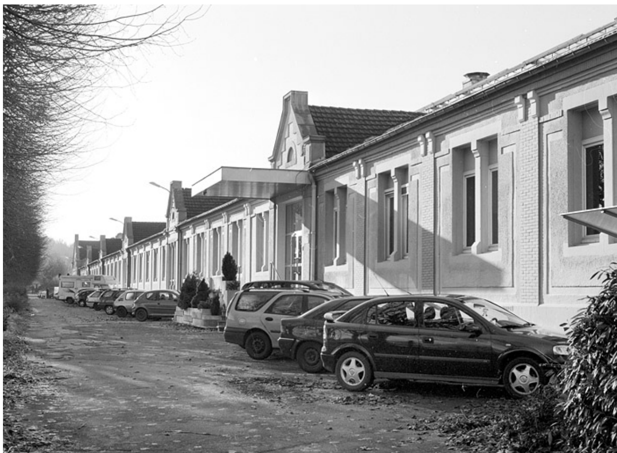
Bâtiment des bureaux et des magasins : façade depuis le nord-est.
