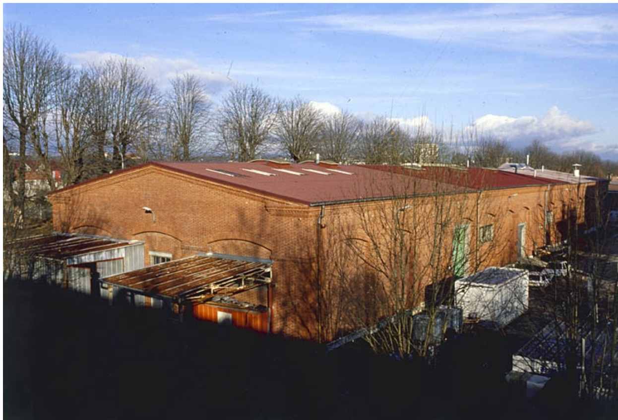
Magasin et entrepôt industriel.
