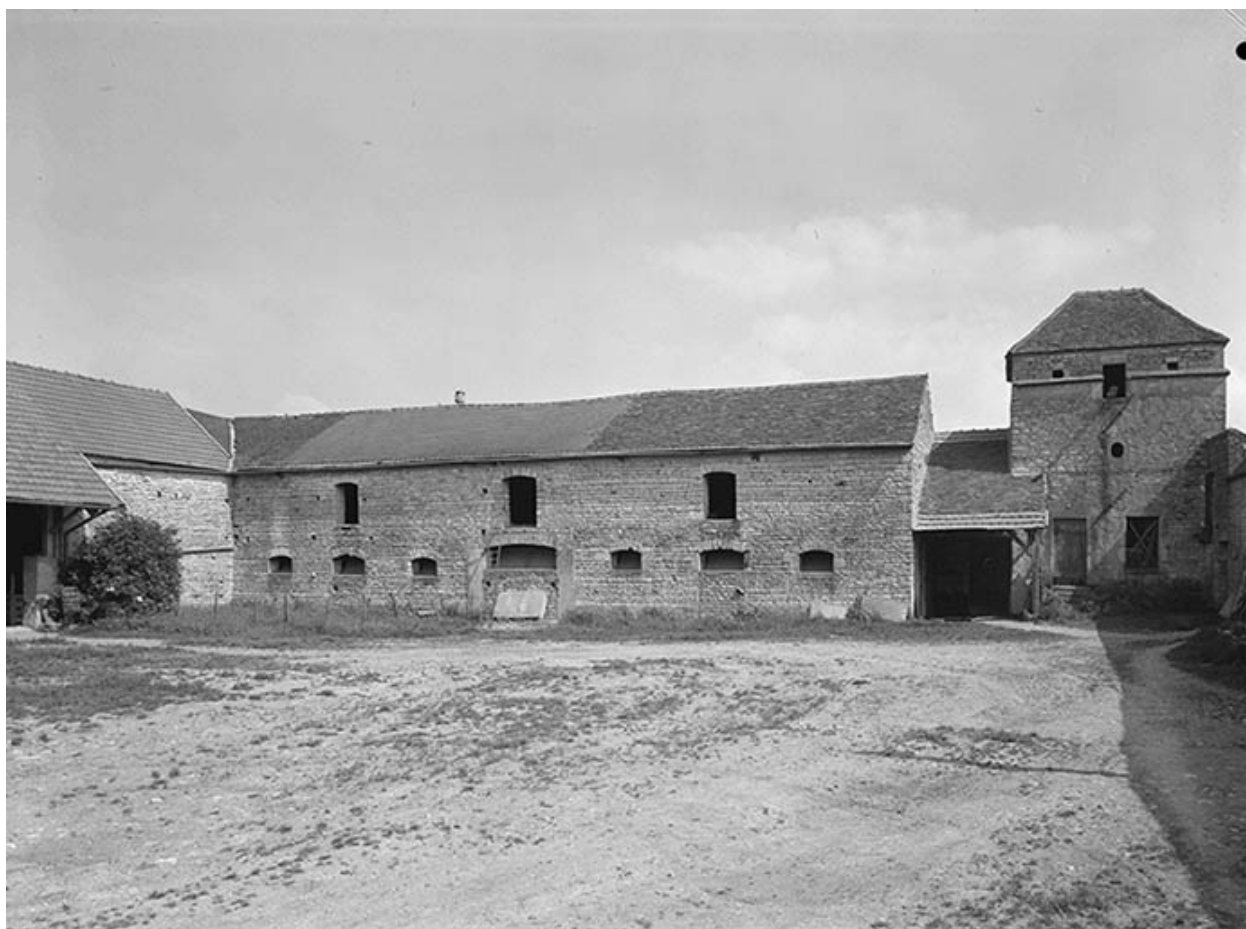
Corps de bâtiments sur cour.
