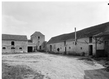
Colombier et corps de bâtiments sur cour. Phot. Michel Thierry IVR26_19748900078V
