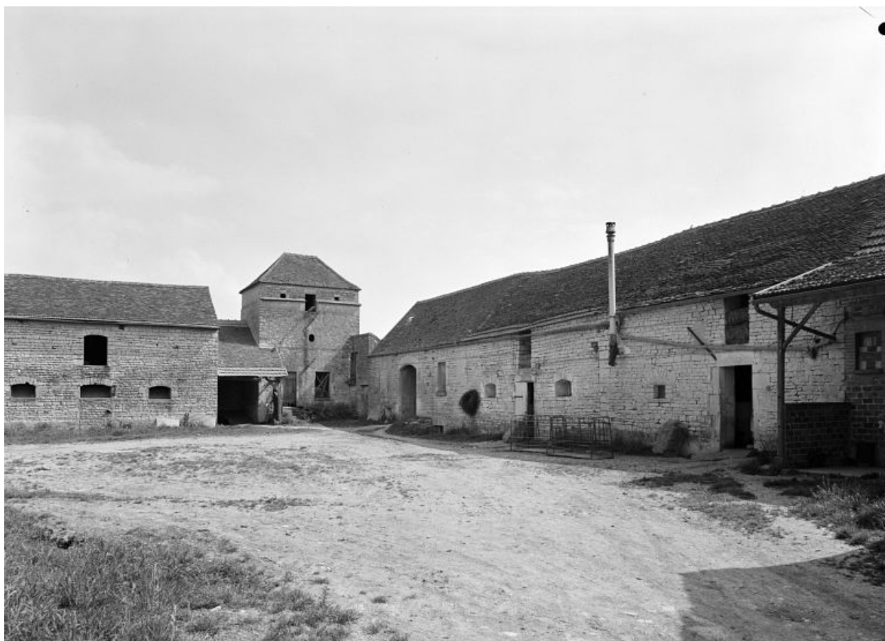
Colombier et corps de bâtiments sur cour.
