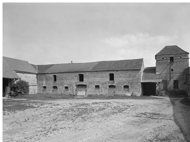
Corps de bâtiments sur cour. Phot. Michel Thierry IVR26_19748900079V
